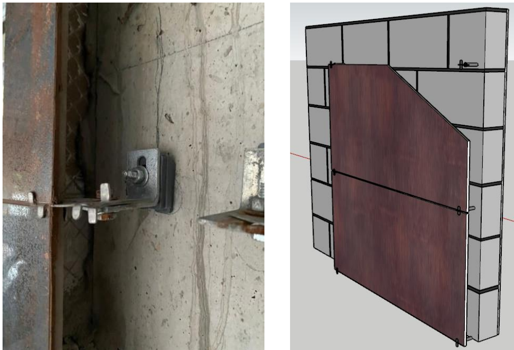
Figura 15 – Composição da parede de envoltória
