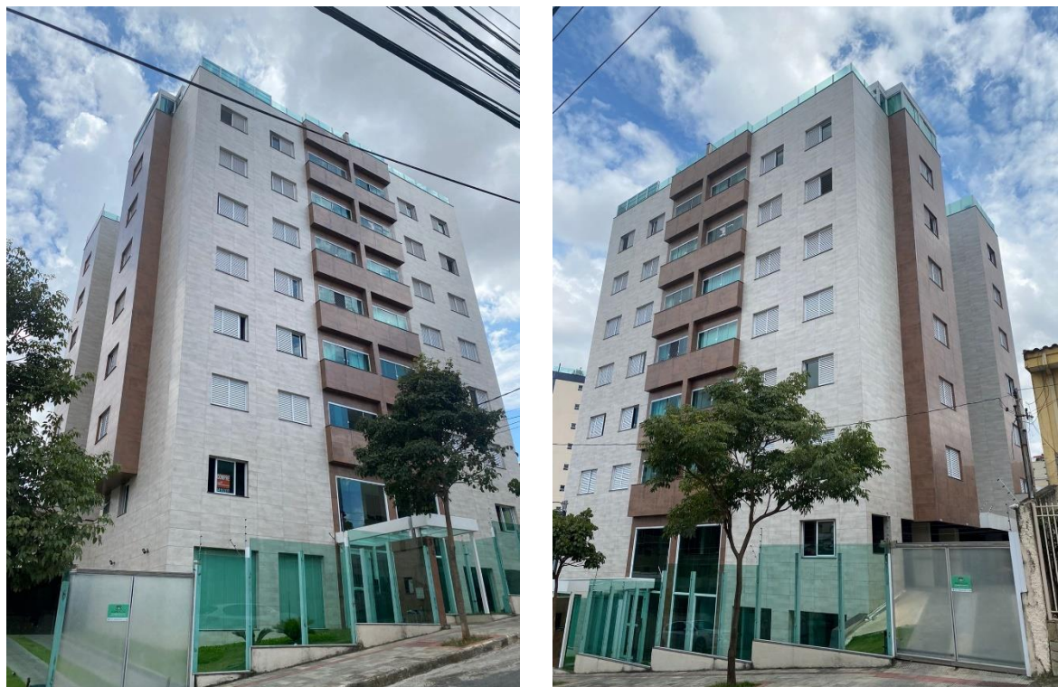
Figura 05 – Fachada da edificação analisada
