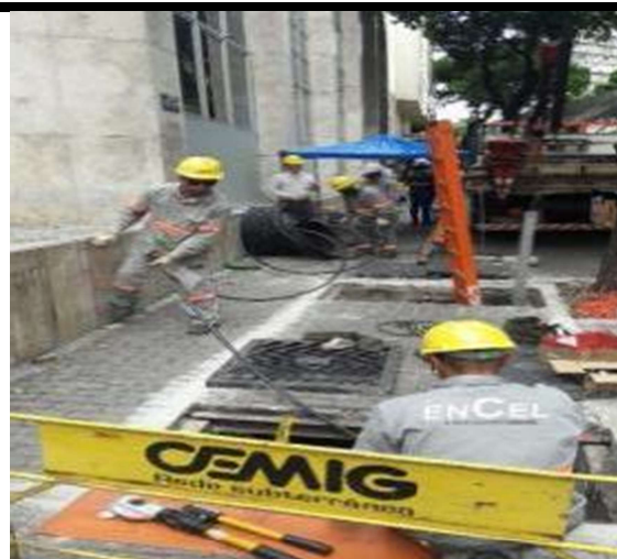
Figura 6. Trabalhadores no lançamento e controle do cabo.
