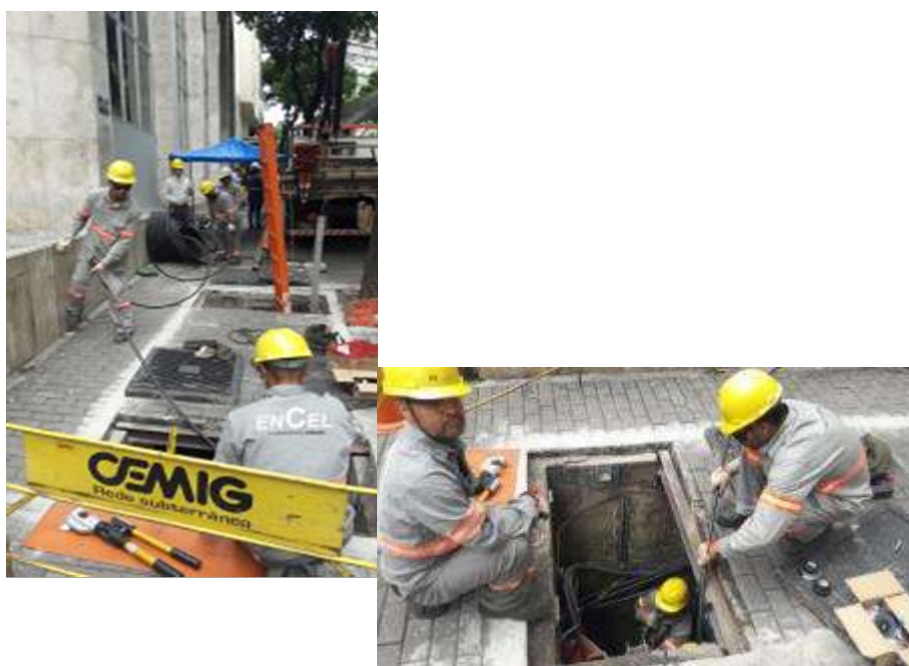
Figura 11. Trabalhadores no lançamento e controle do cabo
