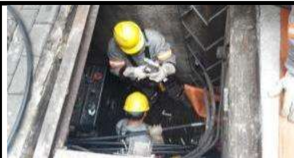
Figura 11. Preparação do Y35 para compressão da luva emenda
