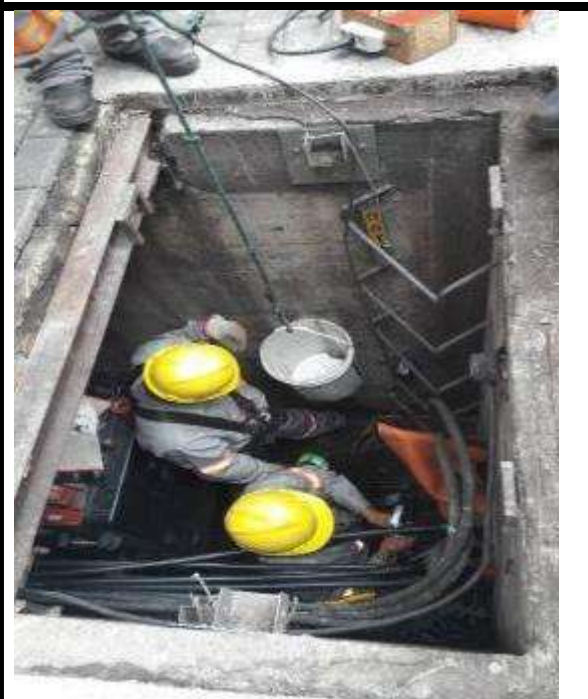
Figura 15. Retirada de água pluvial na câmara
