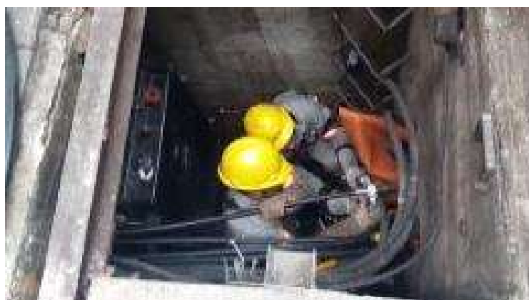
Figura 14. Trabalhador ajoelhado realizando compressão e emenda do cabo
