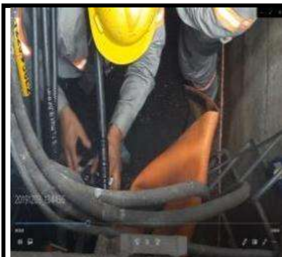
Figura 17. Recomposição do isolamento com fita autofusão
