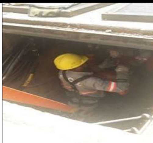
Figura 18. Trabalhador posicionado na escada
