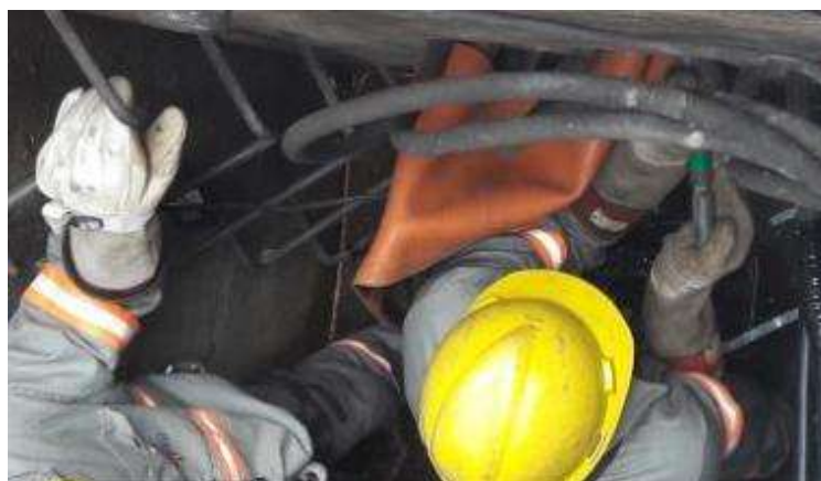
Figura 13. Fixação da luva emenda no cabo energizado
