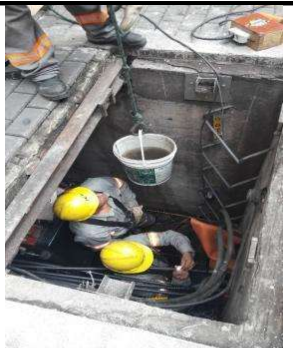
Figura 16. Retirada de água pluvial na câmara
