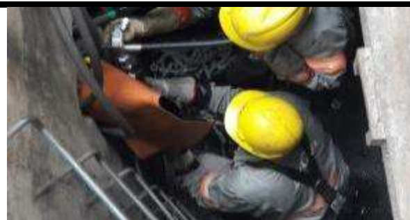
Figura 12. Trabalhador ajoelhado realizando compressão e emenda do cabo
