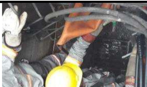
Figura 9. Retirada do isolamento e escovamento do cabo
