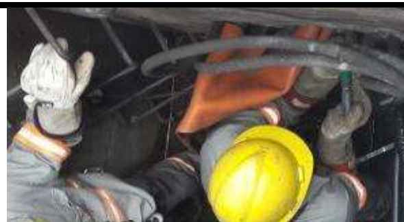
Figura 10. Fixação da luva emenda no cabo energizado
