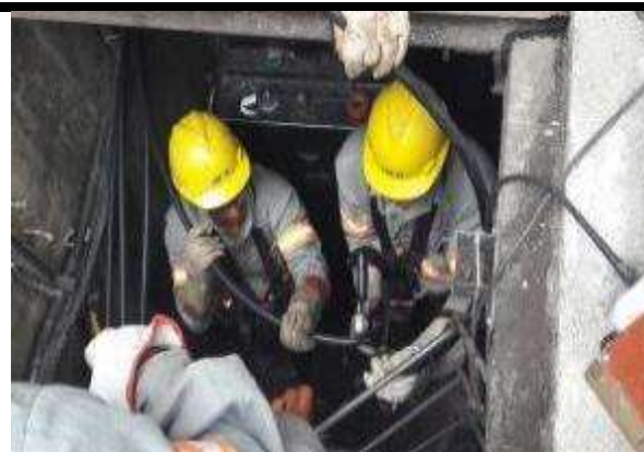
Figura 8. Corte do cabo utilizando policorte
