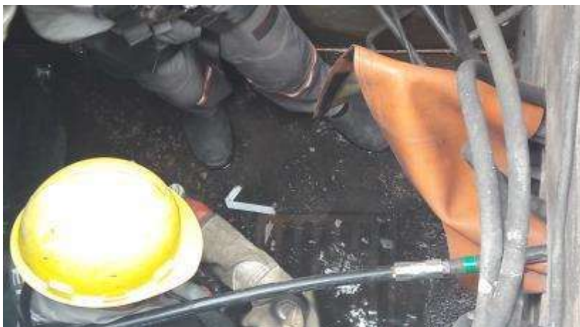
Figura 15. Luva emenda prensada no cabo emendado
