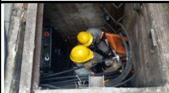
Figura 13. Trabalhador ajoelhado realizando compressão e emenda do cabo
