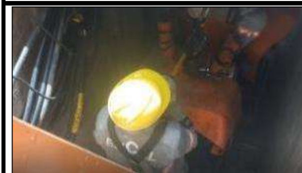
Foto 21. Compressão no terminal do transformador
