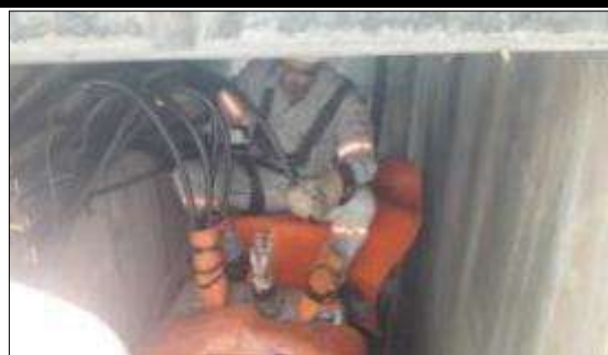
Figura 20. Trabalhador sentado no transformador
