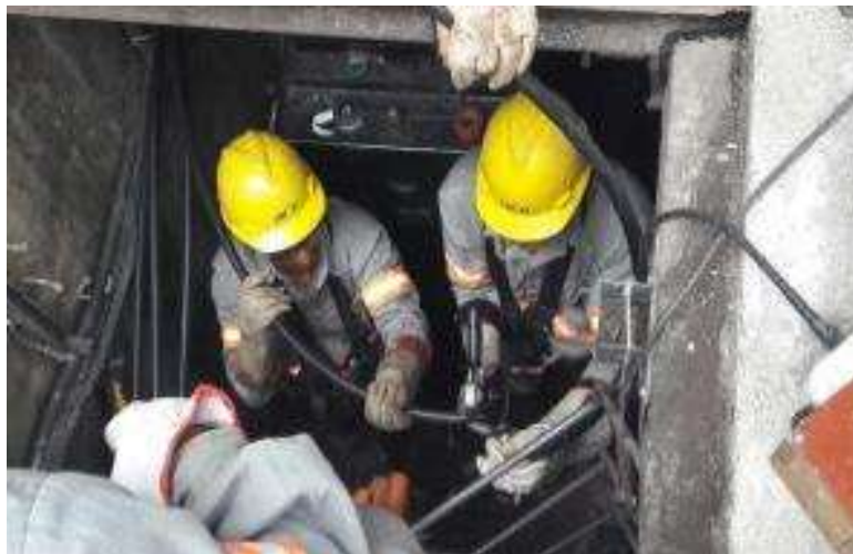
Figura 12. Corte do cabo utilizando policorte
