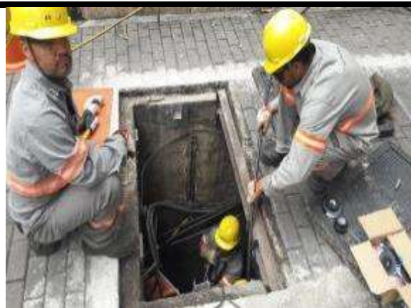
Figura 7. Trabalho na entrada da câmara auxiliando no controle do cabo
