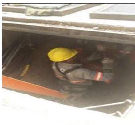
Figura 18. Trabalhador posicionado na escada
