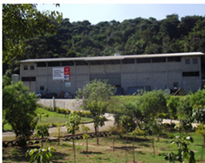
Figura 11: Galpão de Triagem Asmac
