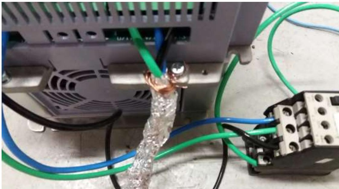
**Figura 3.37 – Aterramento do invólucro de alumínio dos cabos de estator ao dissipador do inversor (Autor).**
