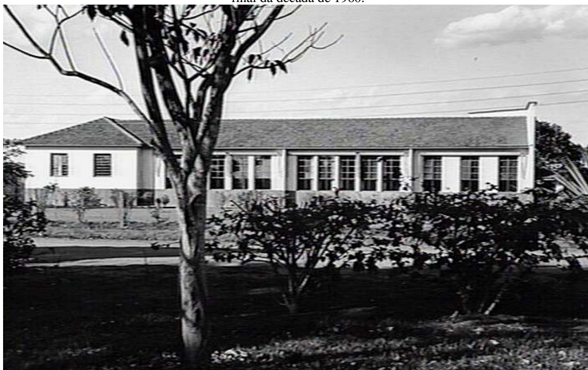
Figura 113 - Edifício da Escola de Economia Doméstica Príncipe Bernardo, visto a partir do jardim do convento, final da década de 1960.
