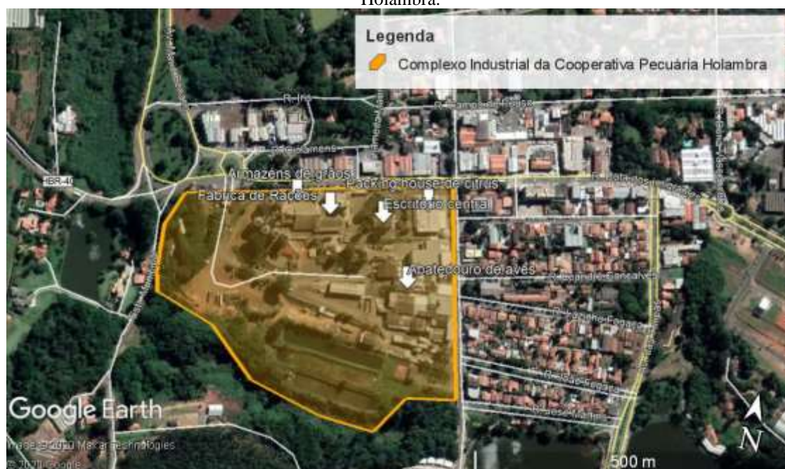
Figura 77 - Localização dos principais elementos do complexo agroindustrial da atual Cooperativa Pecuária Holambra.
