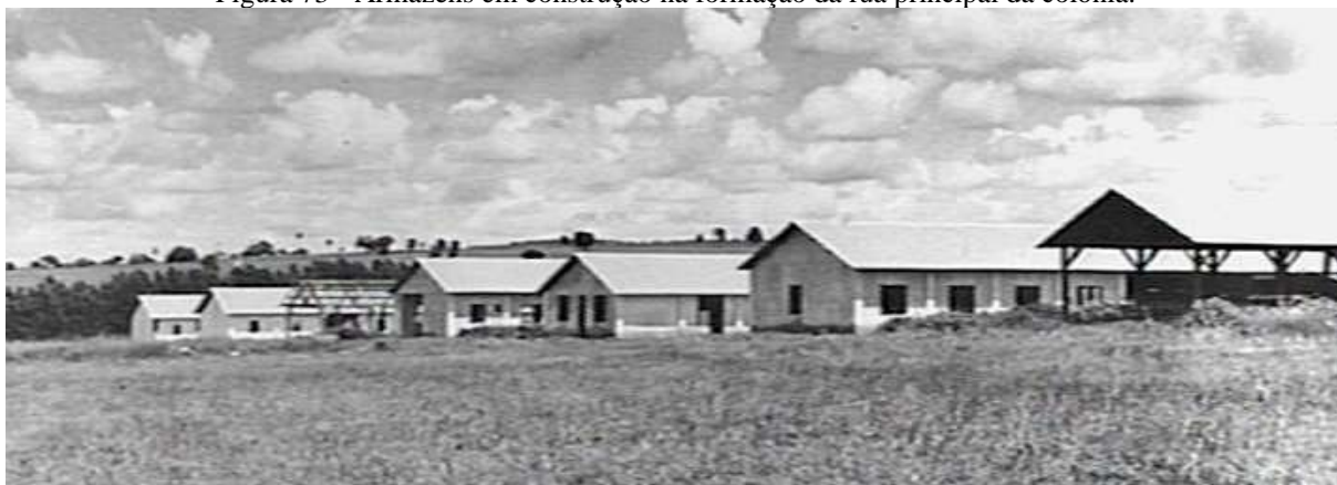
Figura 73 - Armazéns em construção na formação da rua principal da colônia.
