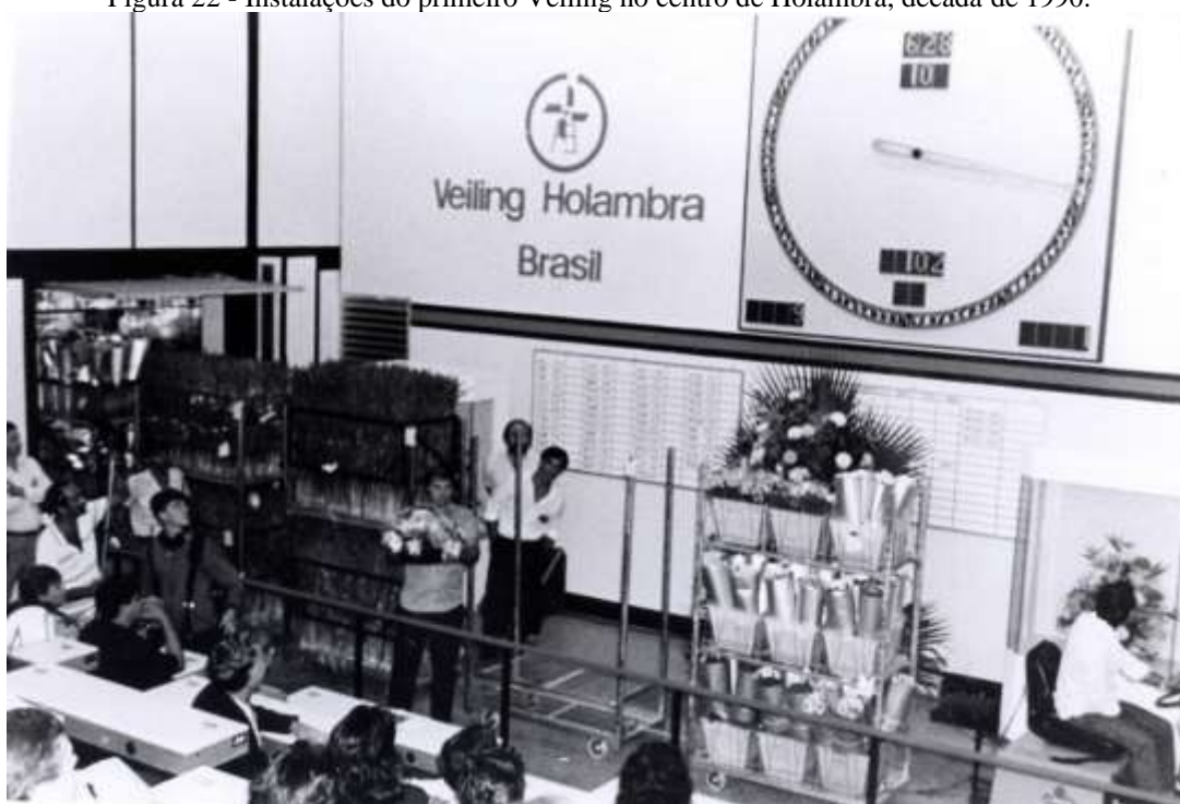
Figura 22 - Instalações do primeiro Veiling no centro de Holambra, década de 1990.
