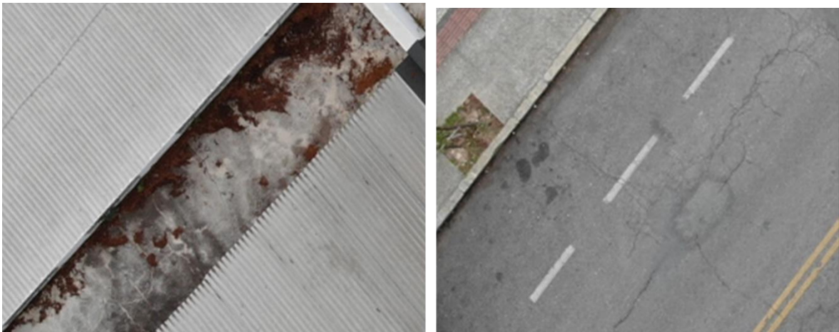
Figura 42: Ampliação do telhado (esquerda) e ampliação da rua (direita).
