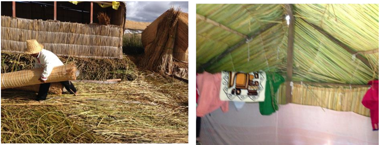
Figura 65: Elevação da base da edificação e estrutura de madeira interna.
