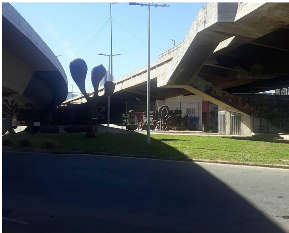
Figura 11 - Viaduto das Artes.
