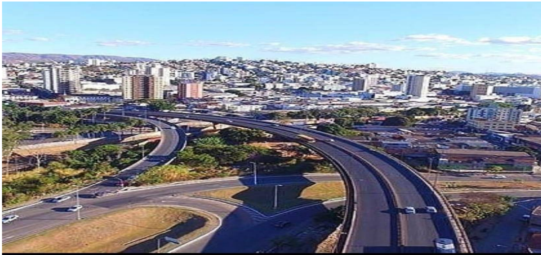
Figura 10 - Viaduto Engenheiro Andrade Pinto.
