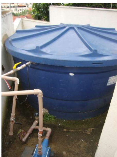
Fotos. 07 e 08: Instalações de bomba, elétrica e automação aparente e exposta a intempéries
