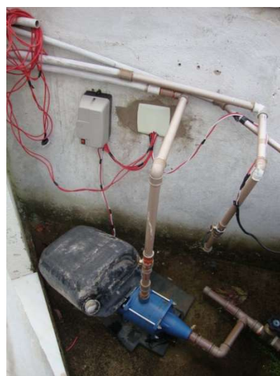
Fotos. 07 e 08: Instalações de bomba, elétrica e automação aparente e exposta a intempéries
