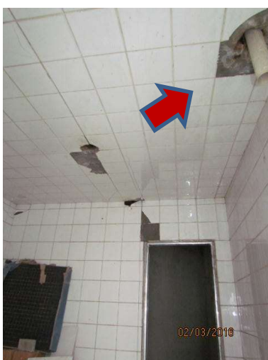
Fotos. 09 e 10: Trincas e rachaduras e deslocamento dos revestimentos cerâmicos, ocasionados por sobrecarga na laje
