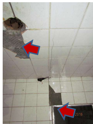
Fotos. 09 e 10: Trincas e rachaduras e deslocamento dos revestimentos cerâmicos, ocasionados por sobrecarga na laje
