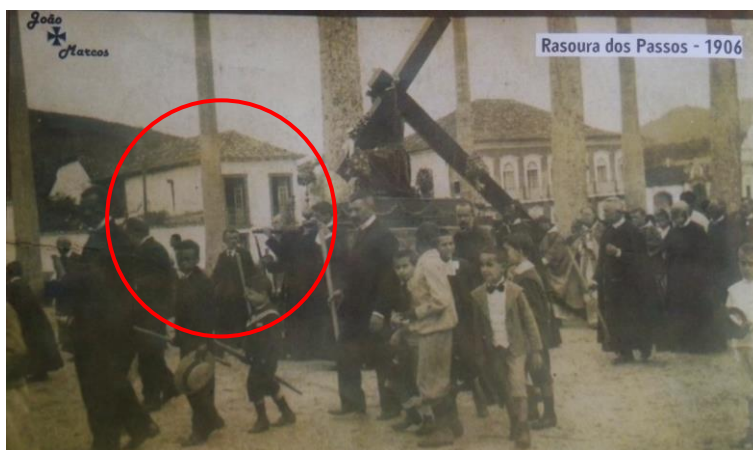
Figura 1 - Vista frontal da Casa de Bárbara Heliodora datada do ano de 1906 (vide destaque). Fonte: Arquivo da Irmandade do Senhor Bom Jesus dos Passos de São João del-Rei.
