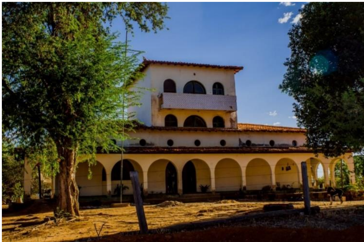
Antiga sede da fazenda Caitité, que hoje faz parte do assentamento Caitité. Foto: Caroline Cunha Rodrigues, 2017. Acervo COVEMG.
