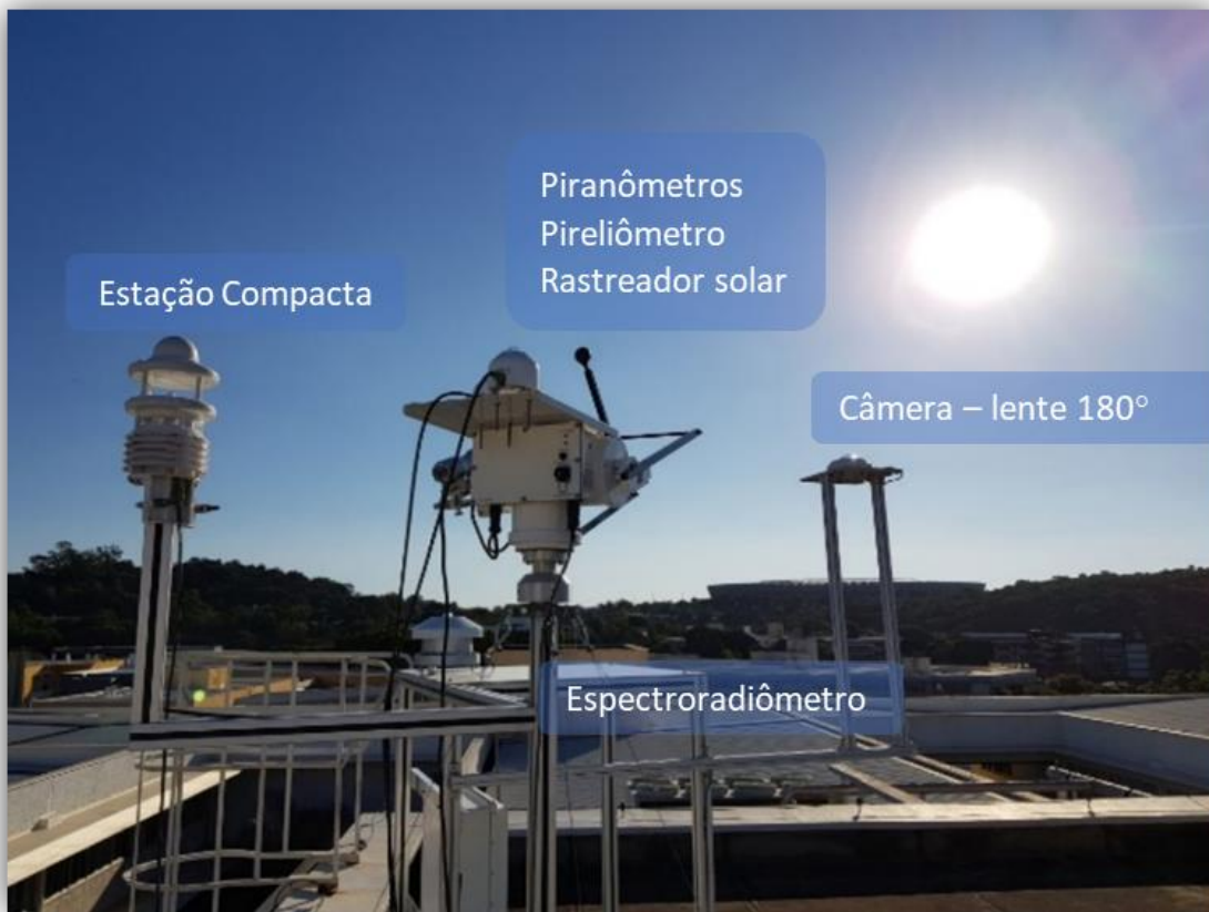
Figura 4.4. Estação solarimétrica-meteorológica instalada na Escola de Engenharia da UFMG.
