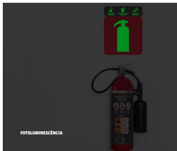
Figura 13: Simulação de uso de material fotoluminescente nas placas sinalizadoras.
