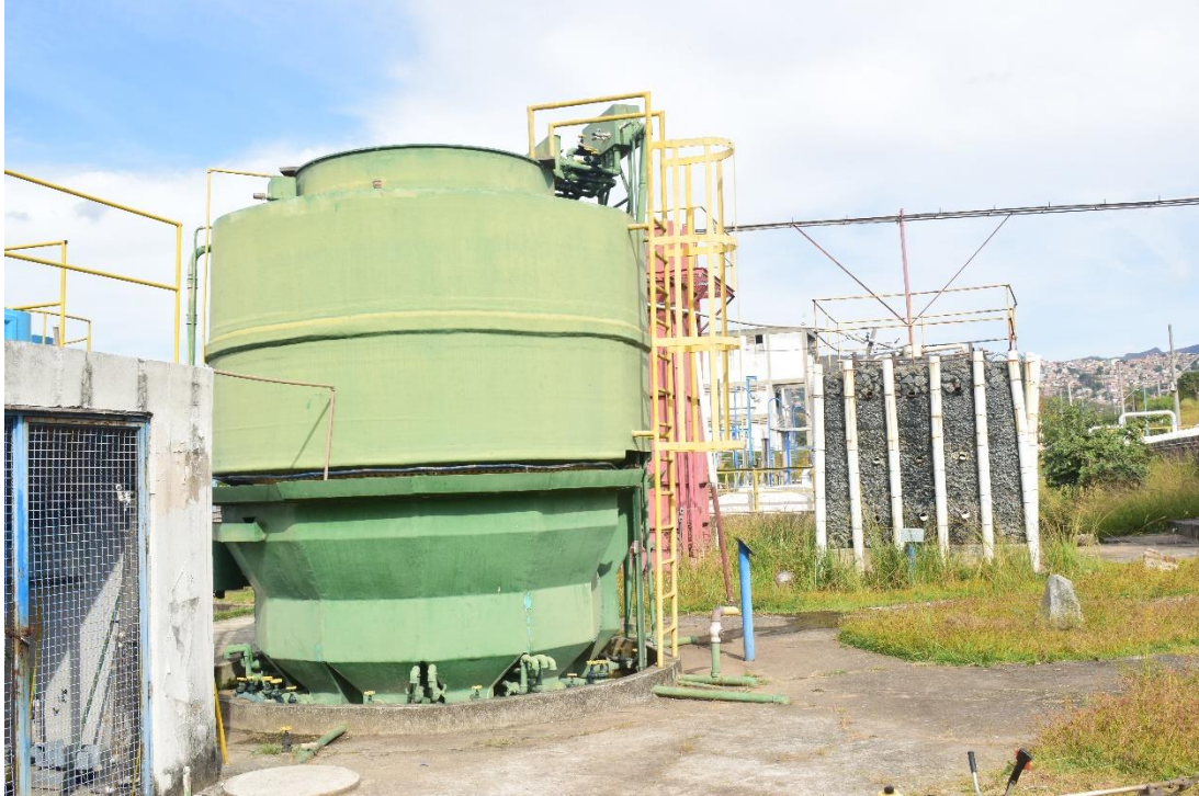
Figura 8: Reator UASB no CePTS utilizado no experimento
