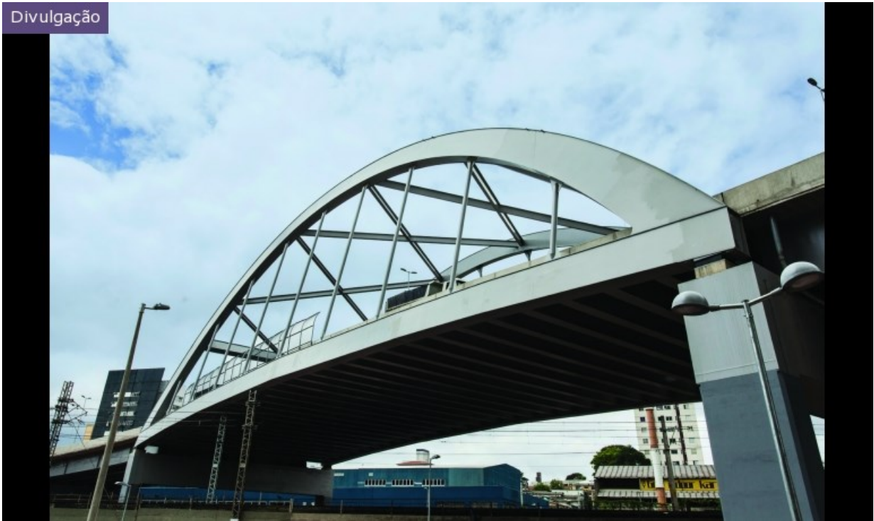
Figura 1. Viaduto Boulevard Arrudas
