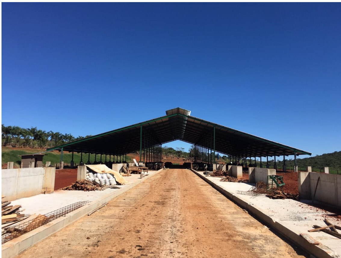
Figura 5 – Visão geral da obra (Acervo pessoal)
