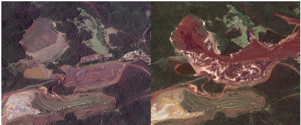
Figura 4.5 - Área da barragem da mina do Córrego do Feijão antes e depois da ruptura da barragem de contenção de rejeitos B1.
