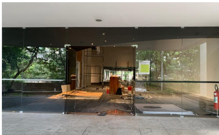
Figura 31 - Foto da entrada envidraçada da sala de exposições do Anexo
