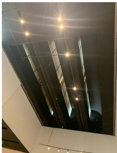
Figura 32 - Sheds para Iluminação zenital e iluminação artificial com trilhos e spots
