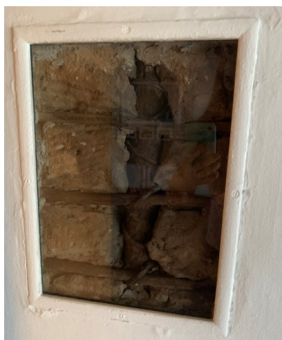
Figura 25 - Janela de prospecção mostrando vedação original do casarão em pau a pique
