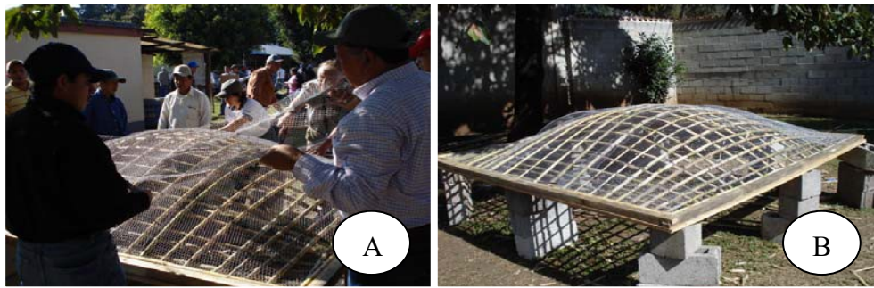
Figura 8 – Processo de revestimento da estrutura Domocaña com tela de galinheiro. Fonte: SANDOVAL (2008)
