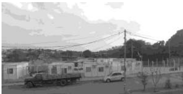
Figura 5: Avenida Dandara asfaltada e Centro de Saúde em 14/09/2018
