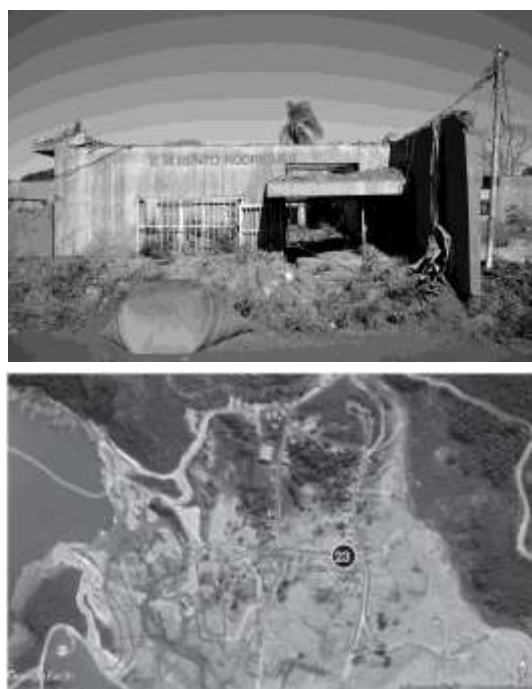
Figura 23: Escombros da Escola Municipal de Bento Rodrigues na visita de 18/6/2016
