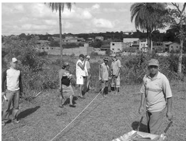
Figura 24: Início dos trabalhos de demarcação no dia 30/05/2009.
