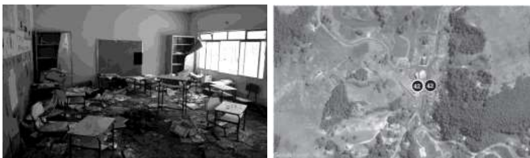
Figura 43: Sala do segundo pavimento da Escola Municipal de Paracatu de Baixo na visita do dia 7/7/2016
