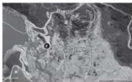
Figura 8: Dique S3 na visita de 18/6/2016
