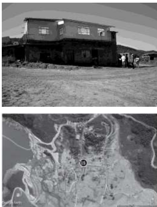
Figura 15: Casa de dois pavimentos na esquina da Rua Olinda e Rua Carlos Pinto
