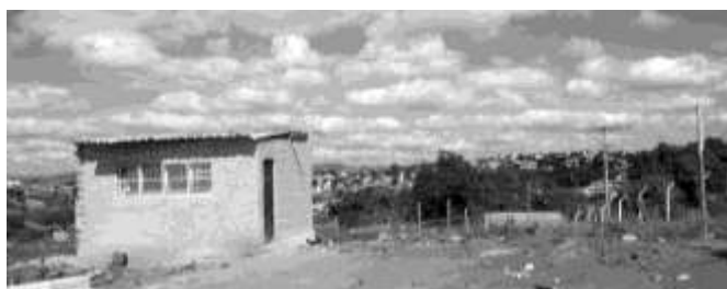
Figura 11: Construção Centro Comunitário Dandara 2010
