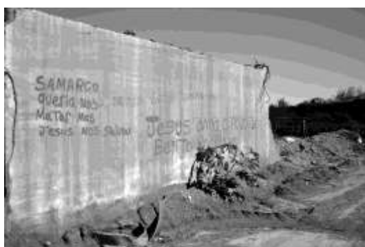
Figura 16: Ruínas da Escola Municipal de Bento Rodrigues com mensagens para a Samarco
