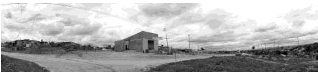
Figura 22: Construção do Centro Ecumênico Dandara em 2011
