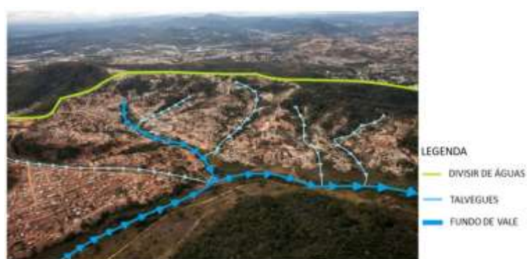
Linhas de drenagem do Córrego dos Macacos - Ocupação Vitória
