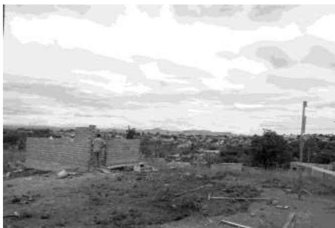
Figura 10: Construção Centro Comunitário Dandara 2009
