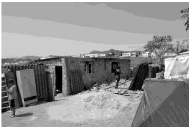
Figura 55: Creche em alvenaria no dia 11/09/2012
