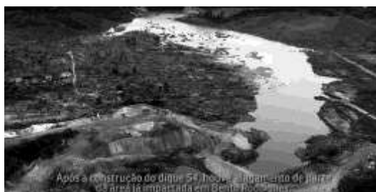
Figura 31: Dique S4 – Sistema de contenção de rejeitos
