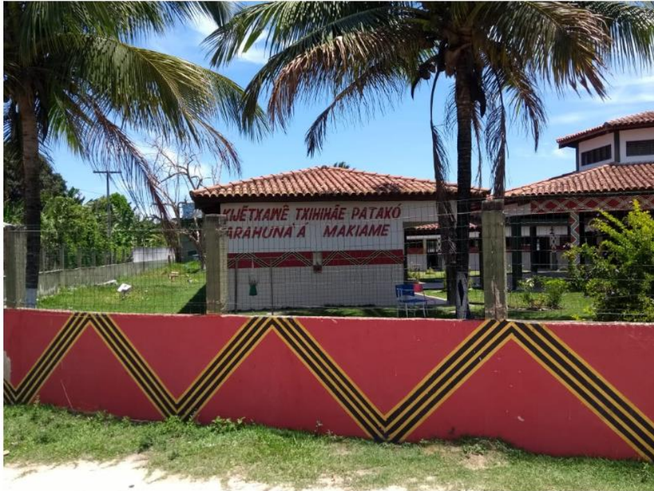
Imagem 11: Prédio da Escola Indígena Pataxó de Barra Velha construído em 2001
