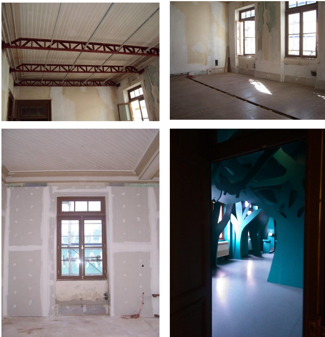
Figura 91 – Fotos das salas onde foram encontradas pinturas originais e seu posterior fechamento com drywall para a instalação do cenário proposto.
