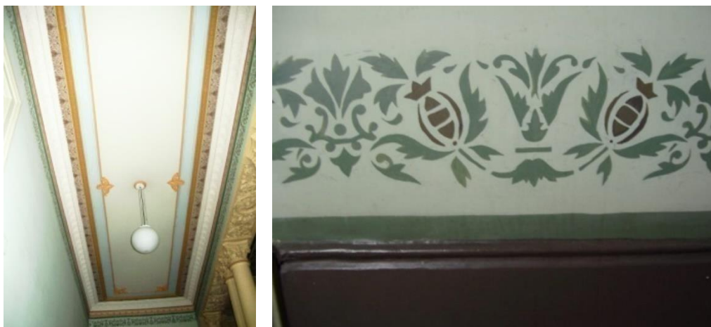
Figura 47 – Detalhe do estado de conservação dos corredores laterais e de prospecções realizadas.
