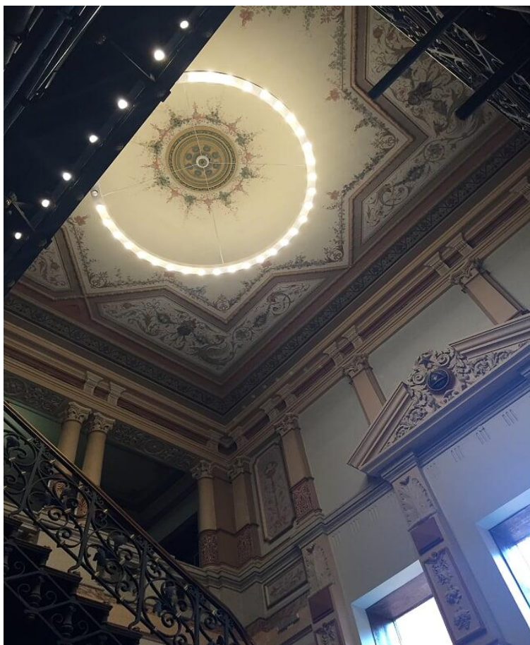
Figura 52 – Vista do forro e de sua iluminação a partir da escadaria.
