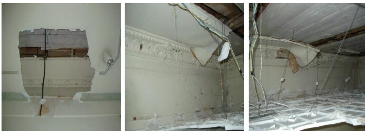
Figura 44 – Detalhe dos forros decorados escondidos acima de forros de gesso liso.
