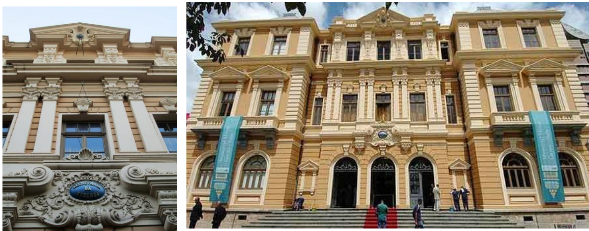
Figura 37 – Fotos do Edifício da Secretaria das Finanças após a restauração.
