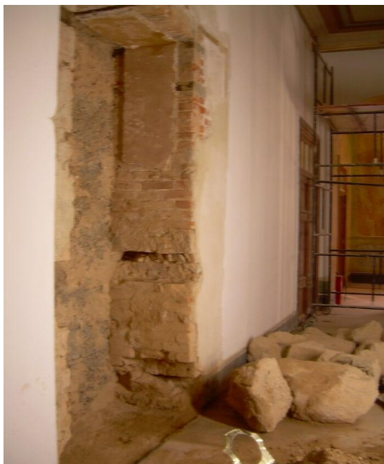
Figura 53 – Foto da prospecção da parede do cofre.
