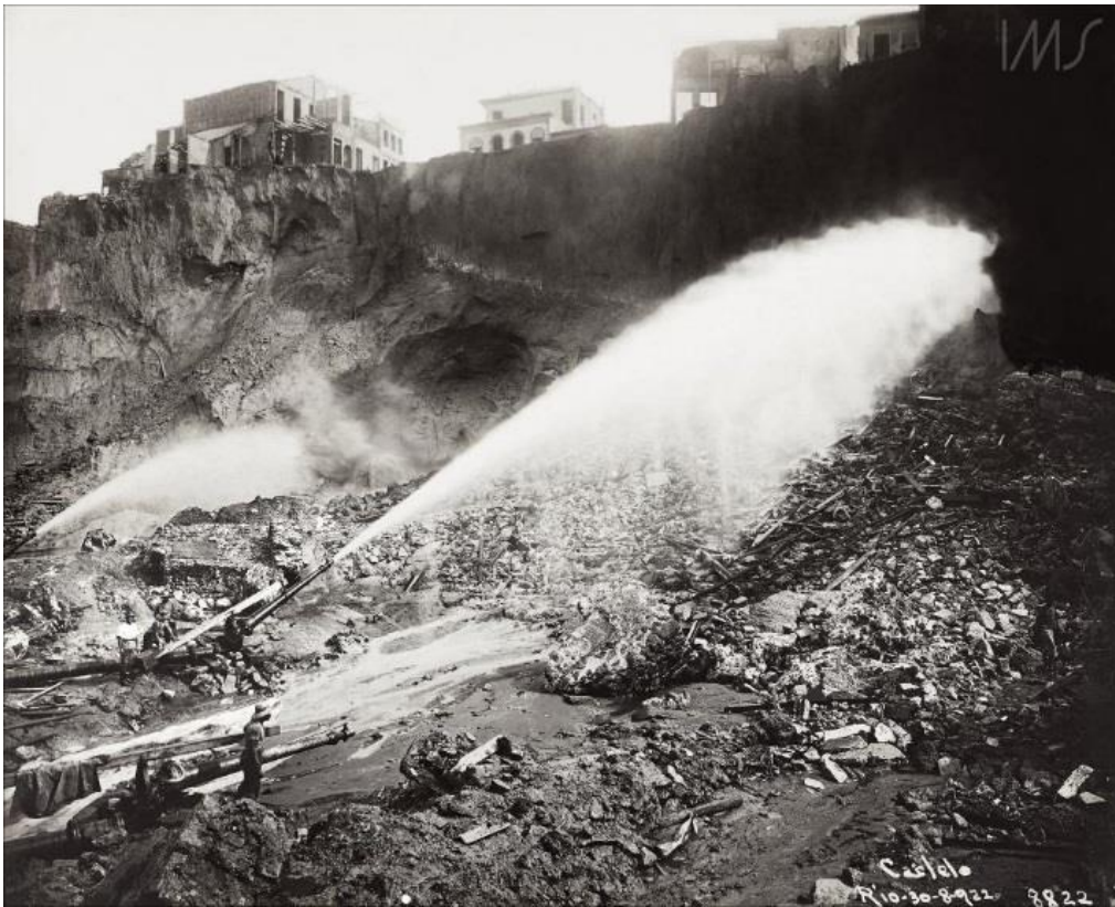
Augusto Malta. Demolição do Morro do Castelo. 1922.
