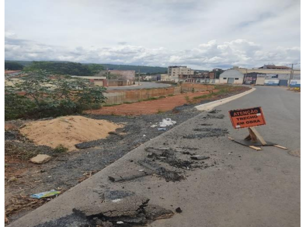
Figura 13. Leito do Córrego Pai Joaquim na chuva.
