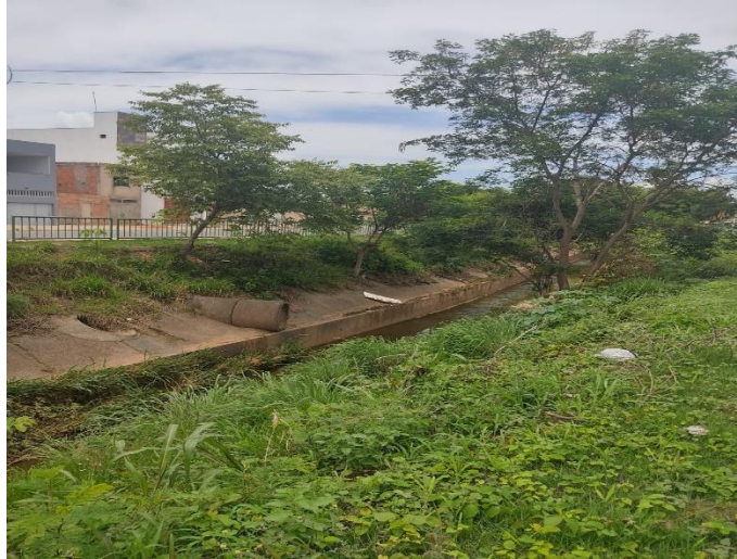
Figura 9. Leito do Córrego Vargem Grande na chuva.
