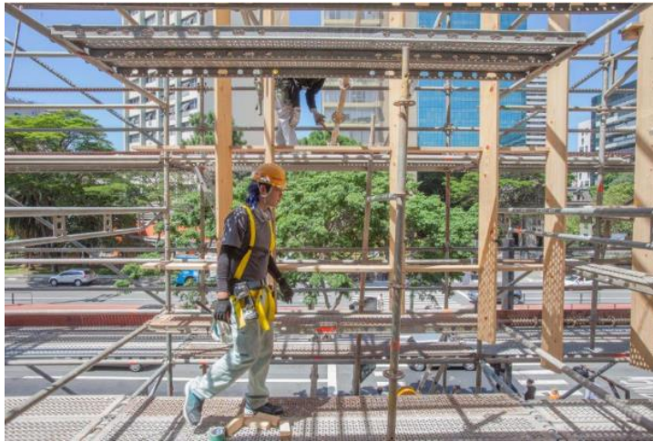
Figura 16 – Execução da estrutura de hinoki
