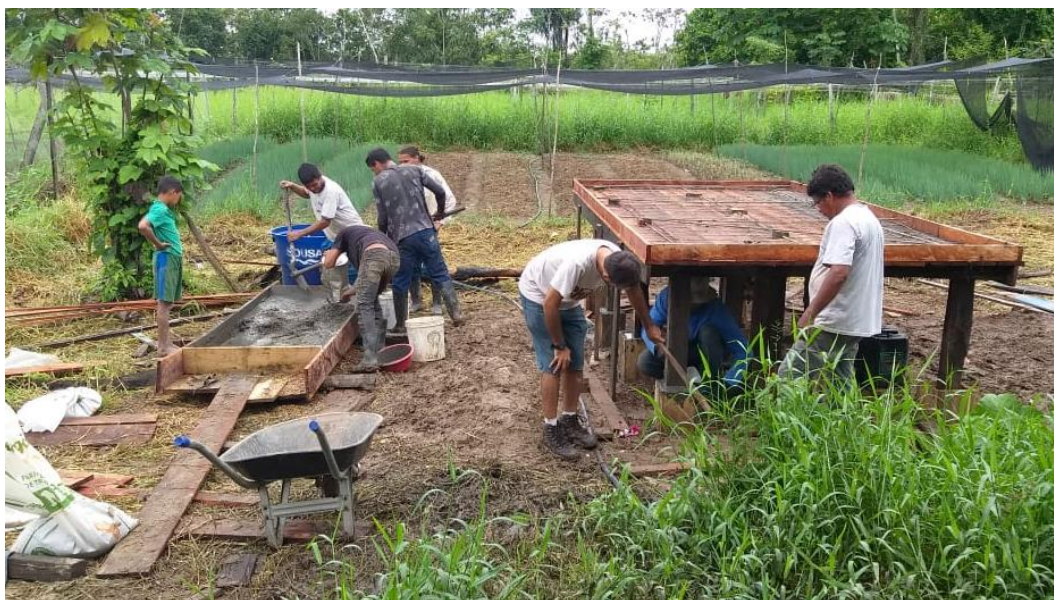
Figura 5.10 – Participação dos moradores da comunidade durante obra de instalação do sistema de tratamento
