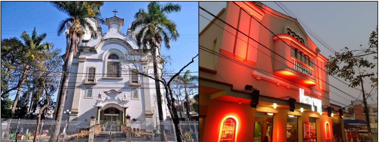
FIGURA 7: À esquerda a Igreja de Santa Teresa e Santa Teresinha – Tombada pelo Conselho do Patrimônio Cultural de BH. À direita, o Museu da Imagem e do Som – MIS Cine Santa Tereza - tombado pela Diretoria de Municipal de Patrimônio Histórico e Cultural de BH.
