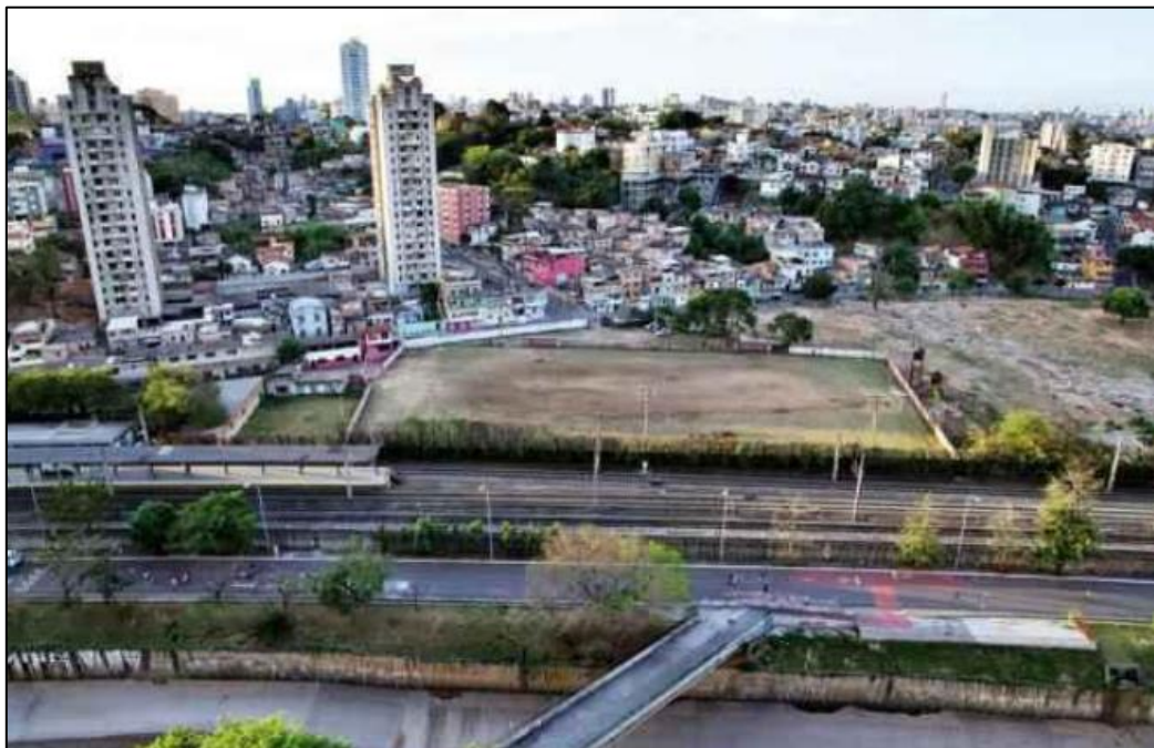
FIGURA 11: Vista panorâmica das “Torres Gêmeas” do bairro Santa Tereza antes de recomeçadas as novas obras após desocupação e leilão dos prédios.
