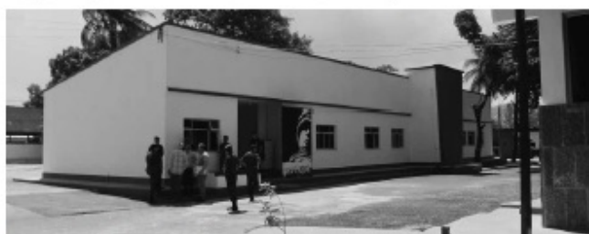
Parte anterior do prédio. Fonte: Arquivo CVV
