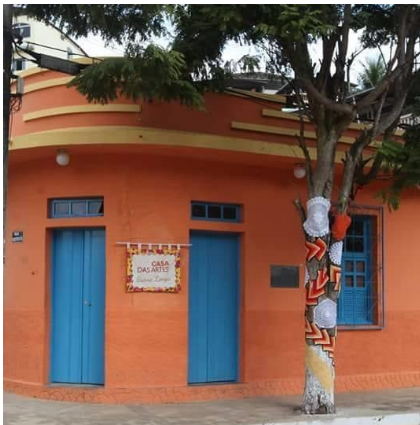
Figura 64 - Fachada externa da Casa das Artes
