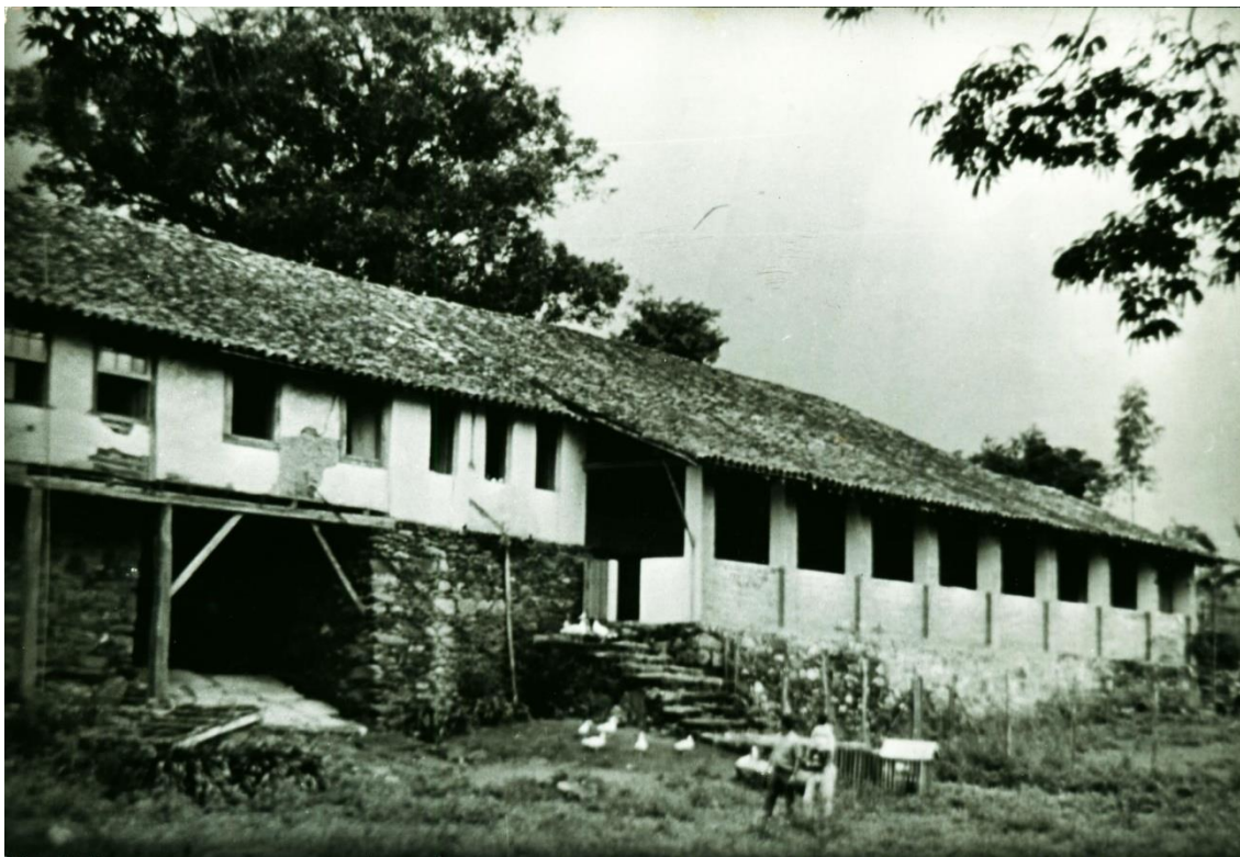
Figura 17 - Fachada dos fundos da sede da Fazenda Borda do Campo
