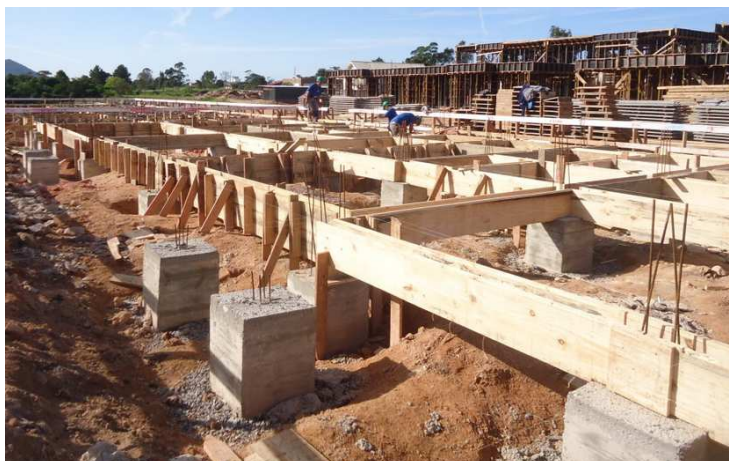
FIGURA 3: Fundação em Cintamento (Internet)
