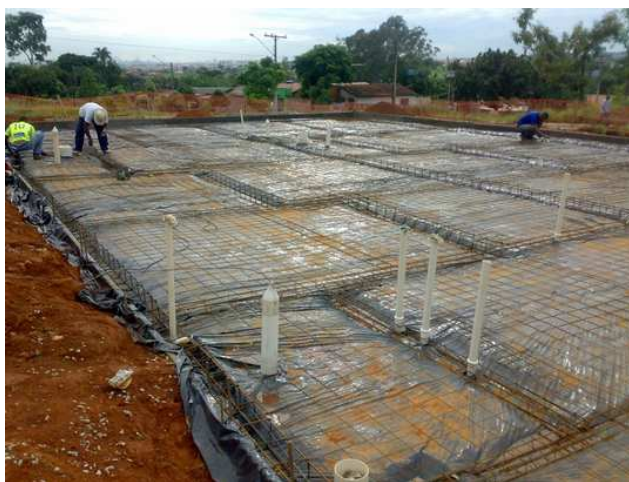
FIGURA 2: Fundação em Radier (Internet)
