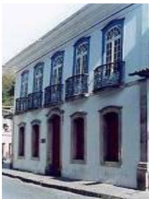
Figura 25 - Sede da FAOP Bairro Rosário – Ouro Preto / MG
