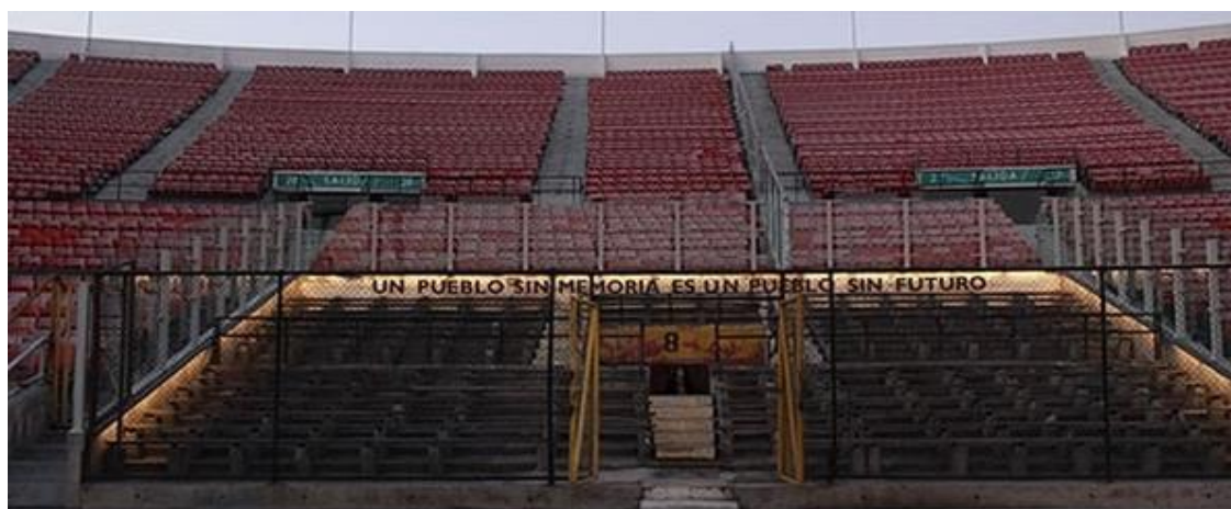
Figura 1 – Graderías de la Dignidad (Arquibancada da Dignidade)
