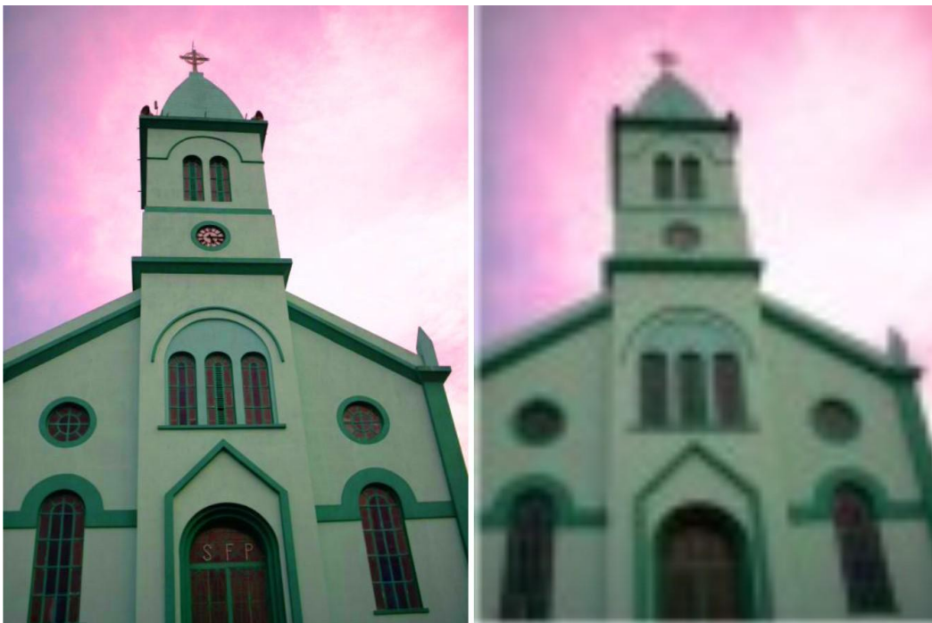
Figura 1 – Igreja de Poço Fundo/MG (Foto Leandro Ferreira)
