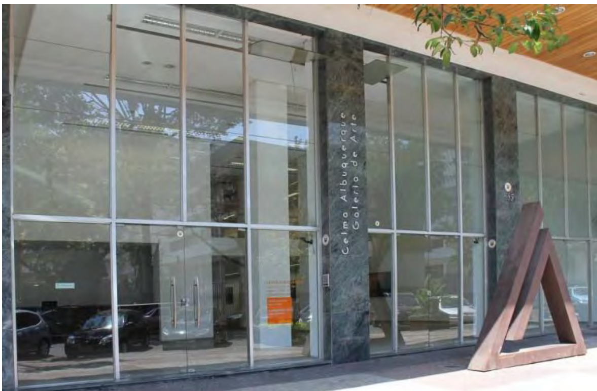
Imagem 20 - Fachada da Celma de Albuquerque Galeria de Arte
