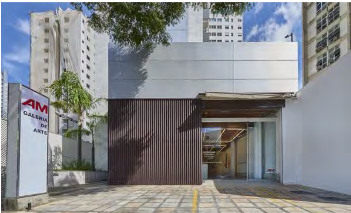
Imagem 12 - Vista da fachada da AM Galeria de Arte
