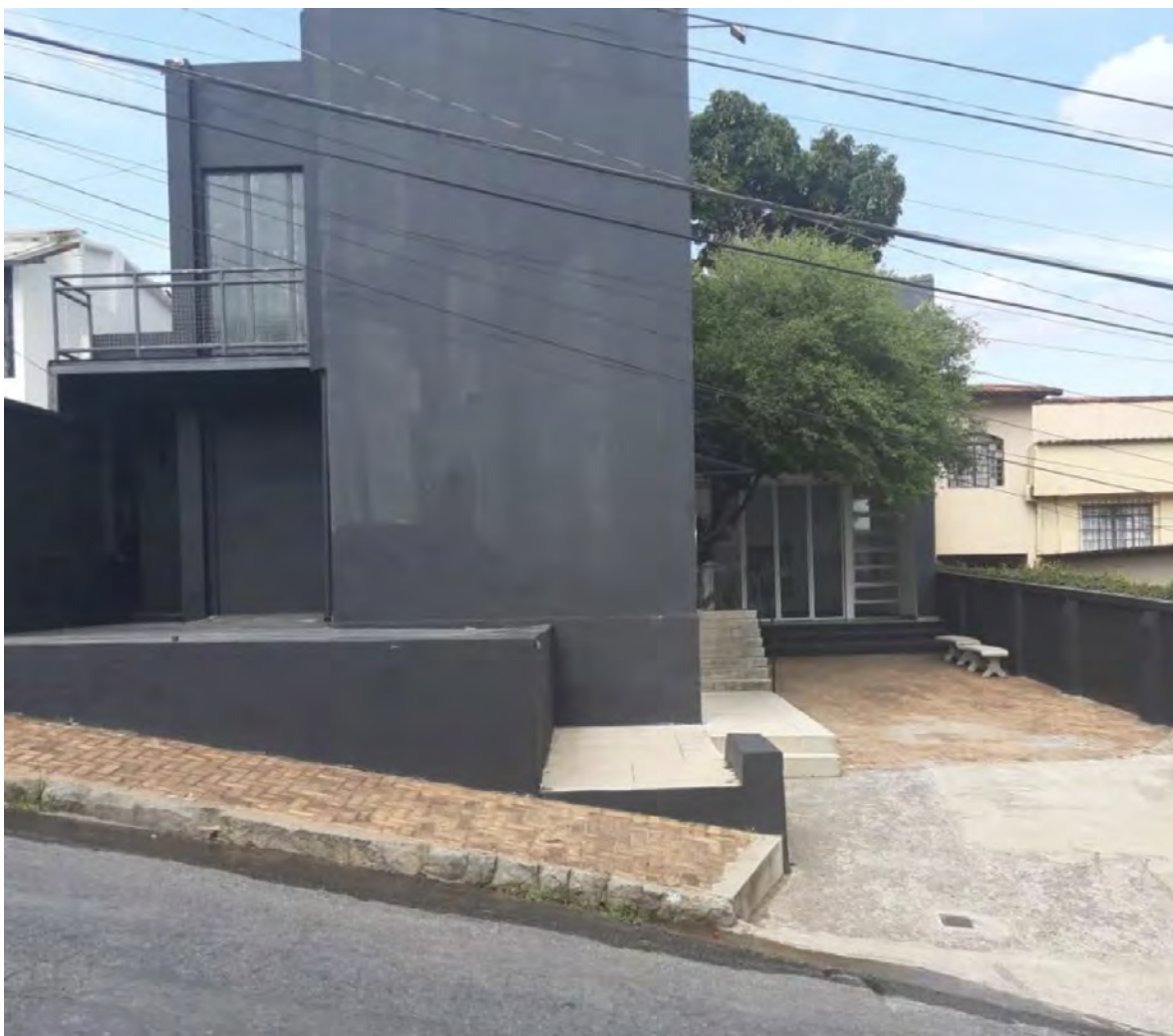
Imagem 7 - Vista da fachada e acesso à Manoel Macedo Galeria de Arte
