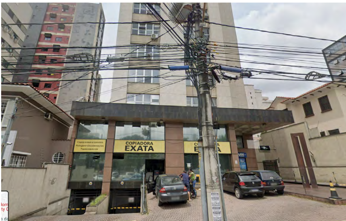
Imagem 51 - Vista da fachada do edifício onde está localizada a Galeria Arte Fasam
