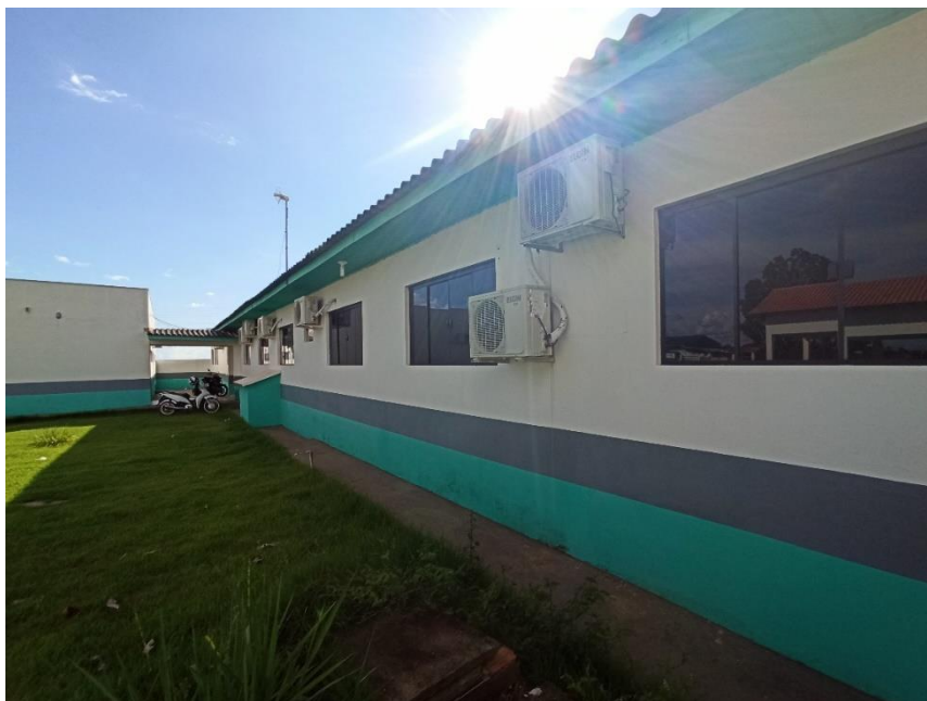
Figura 5 - Fachada sudeste do Bloco A
