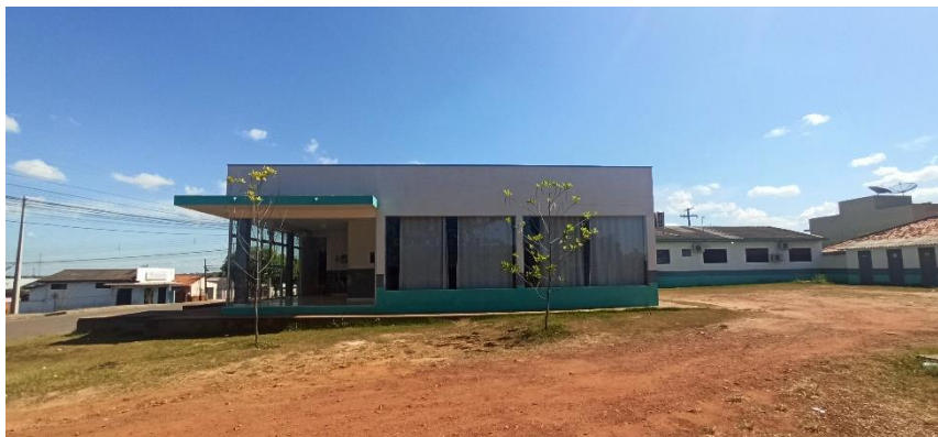
Figura 8 - Fachada sudeste do Bloco B
