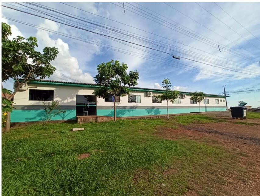
Figura 4 - Fachada noroeste do Bloco A
