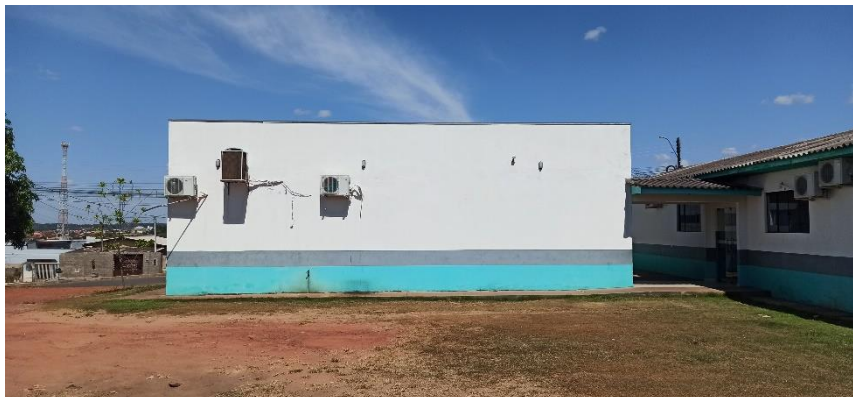
Figura 7 - Fachada nordeste do Bloco B
