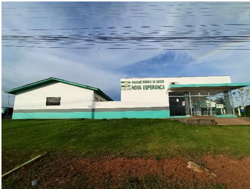
Figura 3 - Fachada sudoeste Bloco A e Bloco B
