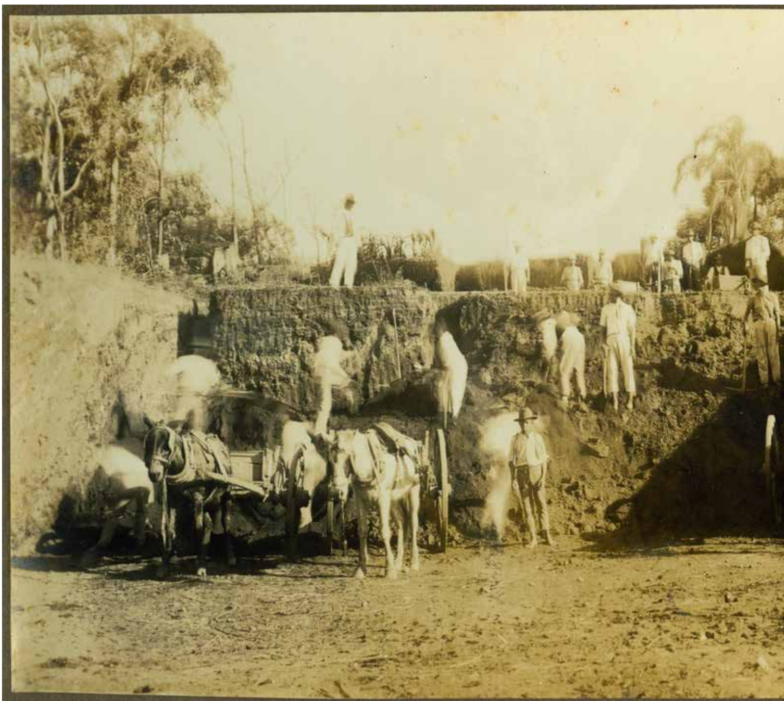
Identificação original Serviços executados durante o governo do Prefeito Flávio dos Santos Entre 7 de setembro de 1922 e 7 de setembro de 1926 Fotógrafo não identificado Obra de desaterro nas margens do Ribeirão Arrudas. Vê-se operários trabalhando e duas charretes no lado esquerdo. Coleção Belo Horizonte Registro: BH.ALB.06/013 Acervo Museu Histórico Abílio Barreto/ Fundação Municipal de Cultura
