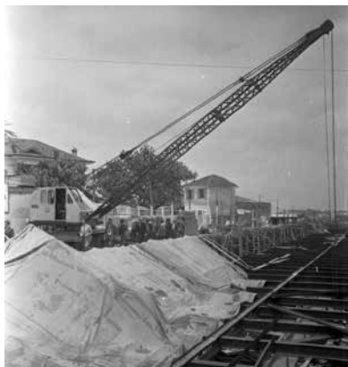
Prefeito visita obras do metrô de São Paulo Prefeito Oswaldo Pieruccetti visita obras do metrô de São Paulo. APCBH/ASCOM
