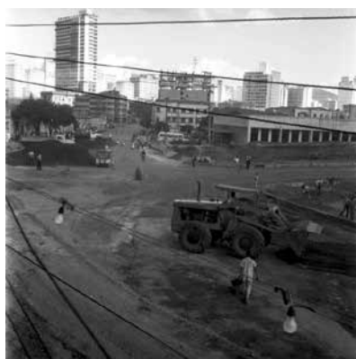
Obras – S/D Rua Paulo de Fronten. Edifício Minas Brasil (o maior ao fundo). APCBH/ASCOM
