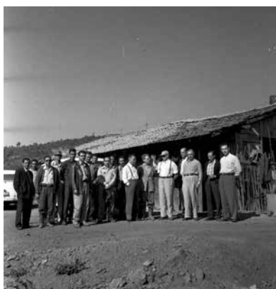
Visita do Prefeito as obras de captação do Rio das Velhas Junho de 1959. APCBH/ASCOM
