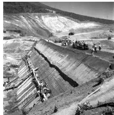
Negativos não identificados - S/D Construção de barragem. Barragem Santa Lúcia (?). APCBH/ASCOM
