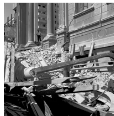
Demolição da Delegacia Fiscal. Avenida Afonso Pena com Alvares Cabral, 1969. Laboratório de Foto-Documentação Sylvio de Vasconcellos.
