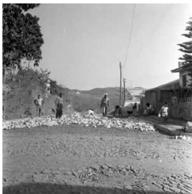
Obras – S/D Obras em local não identificado. APCBH/ASCOM
