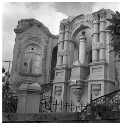
Demolição de Casa na Avenida João Pinheiro, esquina com Rua Timbiras. / 1970. APCBH/ASCOM
