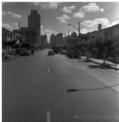
Jardins e Canteiros em diversos locais da cidade – maio, 1973. Rua São Paulo esquina com rua Gonçalves Dias. ASCOM/APCBH
