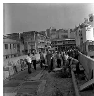
Prefeito e militares visitam diversas obras – out – 1969. Viaduto da Lagoinha. APCBH/ASCOM
