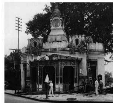
Demolição da Estação de Bonde na Avenida Afonso Penna, 1945, MHAB
