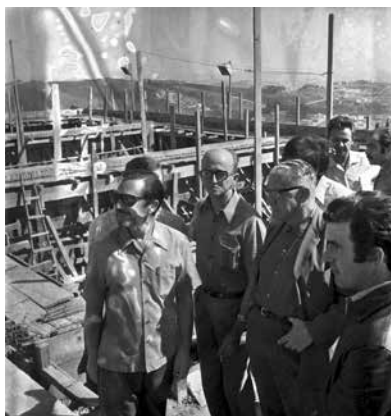
Prefeito visita obras do Reservatório do Morro Redondo – Agosto / 71. Prefeito Oswaldo Pieruccetti visita obras da Estação de Tratamento de água, APCBH/ASCOM
