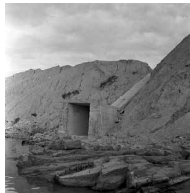
Canalizações Maio de 1959 Aflente canalizado desaguando no rio principal. APCBH/ASCOM
