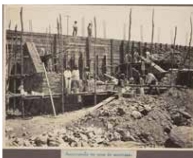
Construção da Casa de Manobras do Reservatório da Pedra Bonita em Belo Horizonte (MG). 1926 - 1930 - Data Provável. Autor : Gines Gea Ribera Fundo : Olegário Maciel Construção Da Casa De Manobras, Obras De Saneamento Na Capital. APM
