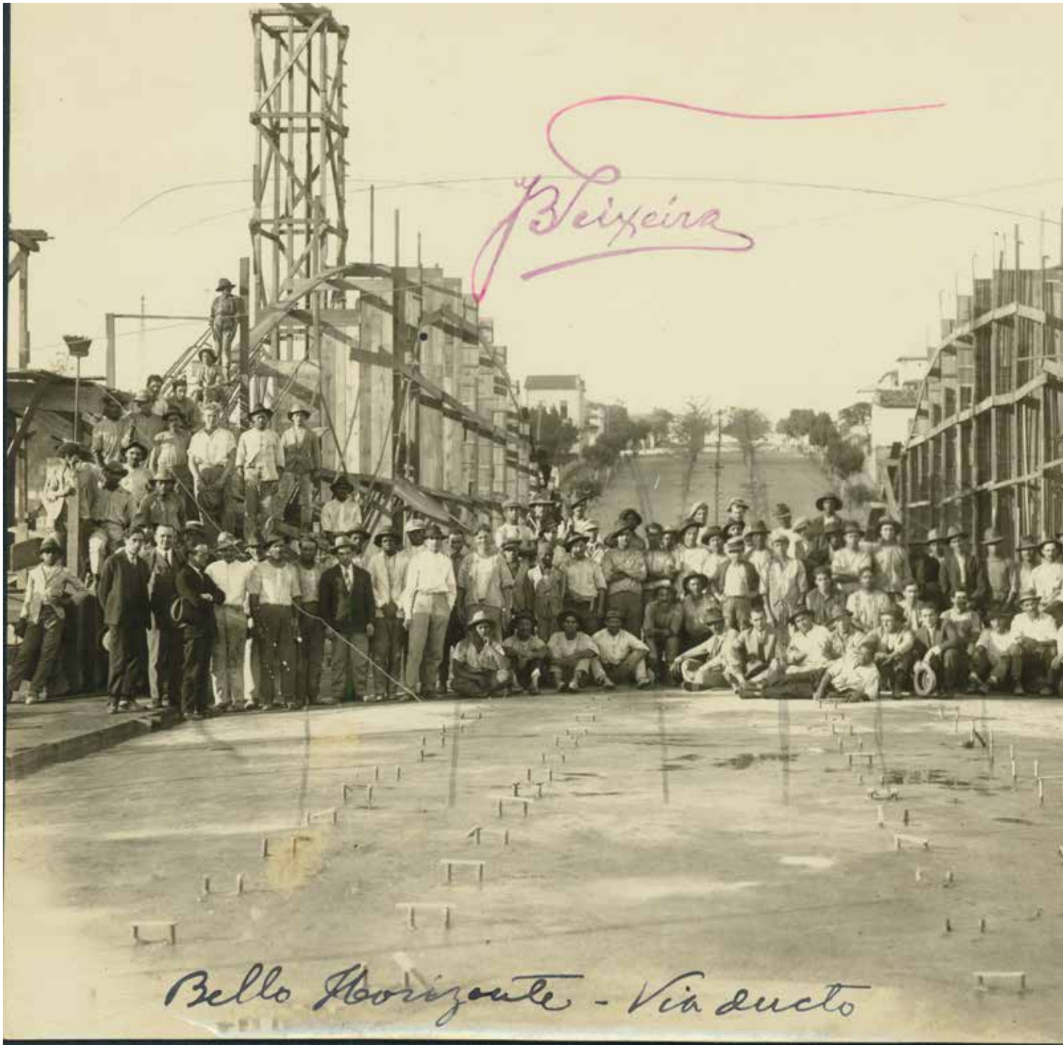
Identificação original Trabalhadores na Construção do Viaduto de Santa Tereza 1928 - Data provável Fotografada por João Almeida Ferber Coleção João Almeida Ferber Notação: JAF-009 Arquivo Público Mineiro
