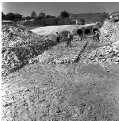
Obras – S/D Obra de canalização. Rua Professor Moraes. APCBH/ASCOM
