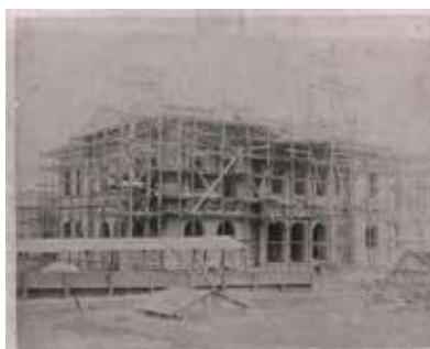
Vista Externa Do Prédio Da Secretaria Da Fazenda Em Construção. 07/08/1894 - 11/11/1896 Autor : Raimundo Alves Pinto Fundo : Secretaria Da Agricultura Secretaria Da Fazenda (Anteriormente Secretaria Das Finanças) 30 De Outubro 96. APM
