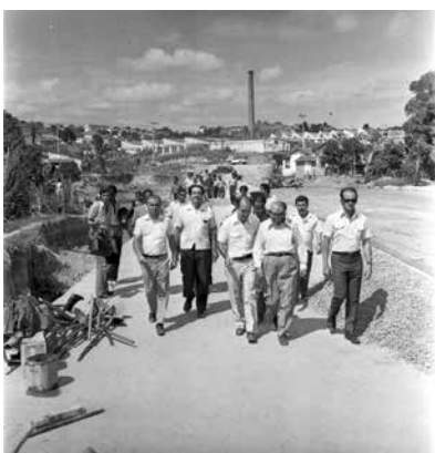
Prefeito visita diversos locais de obras – Fevereiro / 1973. APCBH/ASCOM
