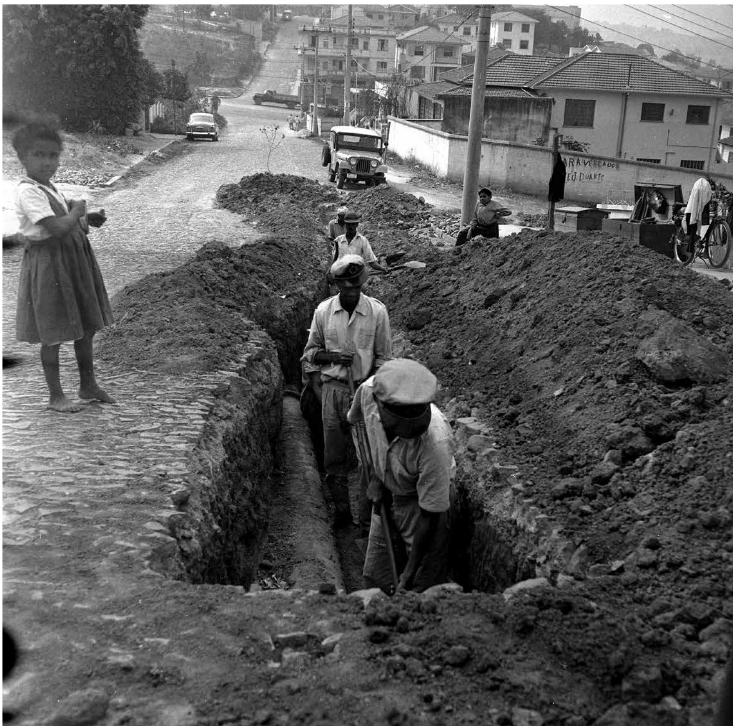
Identificação original Rebaixamento da rede d'água, rua André Cavalcanti Sem data Fotógrafo não identificado Trabalhadores realizam obra em rua. Fundo da Assessoria de Comunicação Social do Município – ASCOM (1947-2015) Identificação: 21501 ASCOM/APCBH Arquivo Público da Cidade de Belo Horizonte/ Fundação Municipal de Cultura
