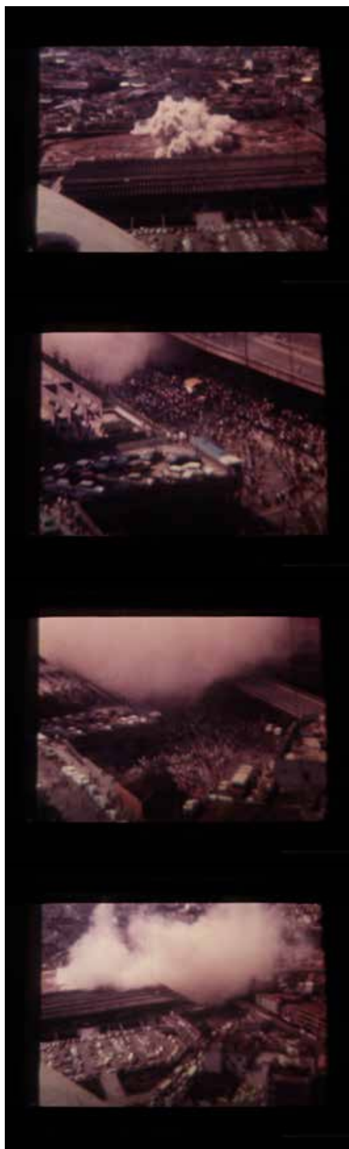
Frames do vídeo Implosão Lagoinha JS 17 -10-1981 Fundo Rede Globo Negativos Acervo MIS/BH
