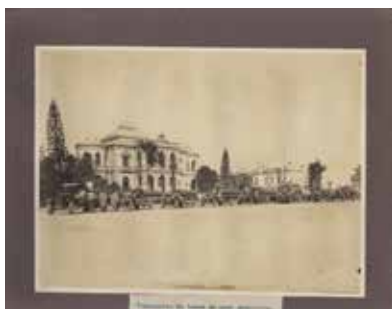
Transporte de tubos para abastecimento de água em belo horizonte (MG). Autor: Gines Gea Ribera, 1926 - 1930 . Fundo OM, APM.
