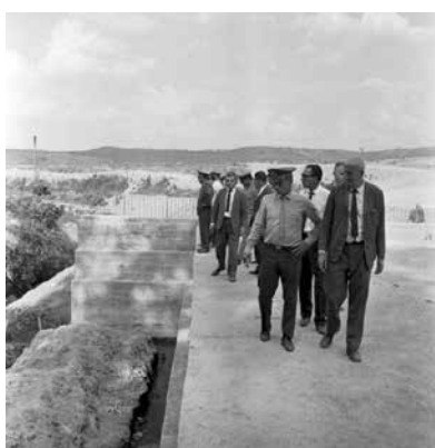
Prefeito e militares visitam diversas obras – out – 1969. Prefeito visita obra. APCBH/ASCOM
