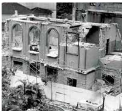
Demolição do Cine Teatro Metr pole , 1983, Pedro Graeff Estado de Minas.
