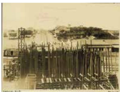
Vista Parcial da Construção do Viaduto [Santa Tereza]. 30/04/1928 Autor : João De Almeida Ferber Viaducto-B.h.te 30-04-28. APM
