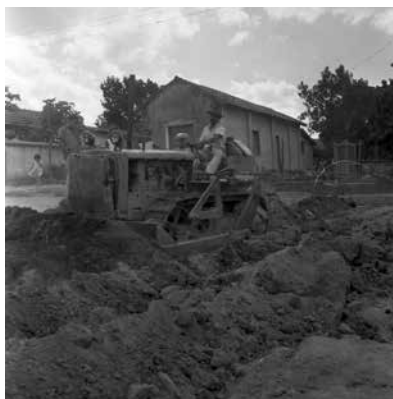
Obras diversas Maio de 1959 Obra de asfaltamento. APCBH/ASCOM
