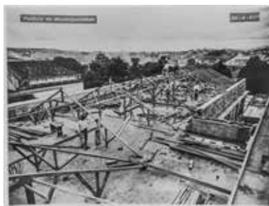
Construção do Palácio da Municipalidade, 30/05/1936, Acervo MIS BH
