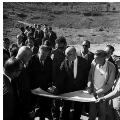
Prefeito visita diversas obras – 07/1968. Prefeito, Sousa Lima visita obras. APCBH/ASCOM
