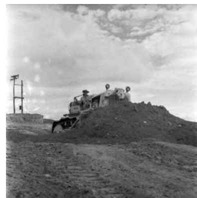
Morro Redondo Movimento de terra para estação de tratamento – S/D. Reservatório no Morro Redondo. APCBH/ASCOM
