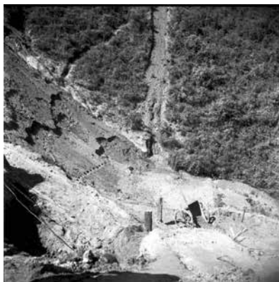
Córrego do Leitão – S/D Canalização do córrego do Leitão. APCBH/ASCOM
