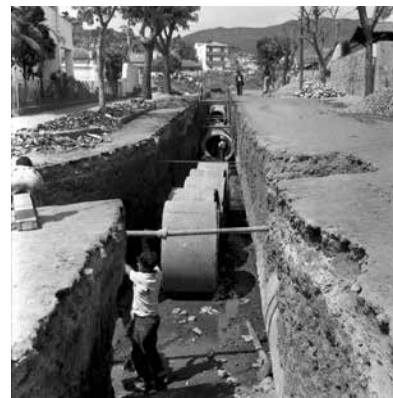
Obras – S/D Obra de asfaltamento. Local não identificado. APCBH/ASCOM
