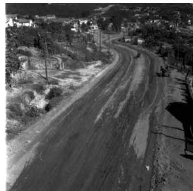
Av. Havaí serviço de terraplanagem – S/D. Obras de terraplanagem na Avenida Havaí. APCBH/ASCOM
