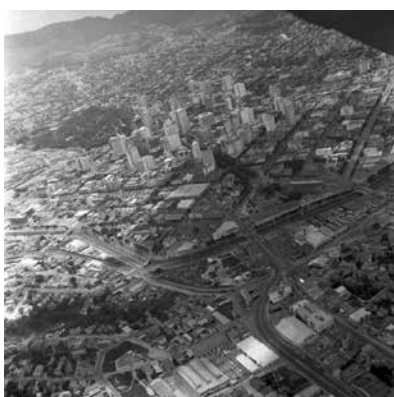
Avenida Afonso Pena. Ao centro e à direita, Feira de amostras. ASCOM/APCBH
