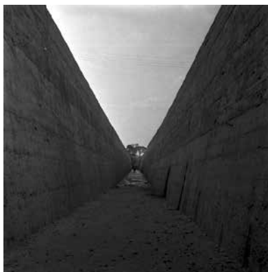
Canalizações no Barreiro – S/D Canalização de córrego no bairro Barreiro. APCBH/ASCOM
