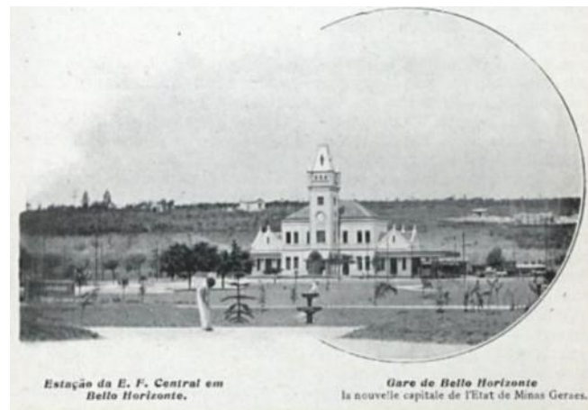
Figura 6: Estação de Minas em 1895 (Fonte: Portal Estações Ferroviárias, 2022)
