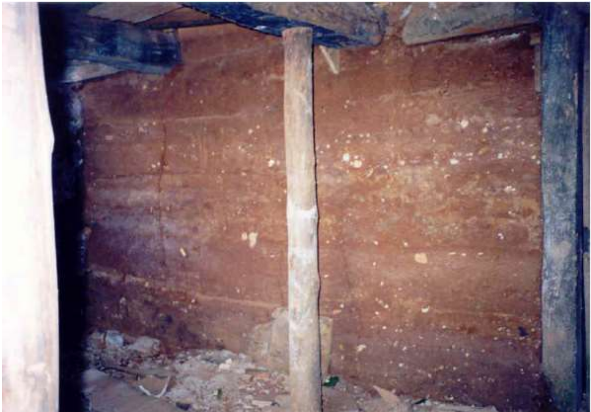
Figura 6 – Modelo de Taipa de pilão - Casa Quatro Cantos – Tiradentes
