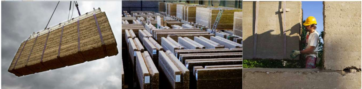
Figura 15 – Processo de montagem em obra de painéis de taipa pré-fabricado
