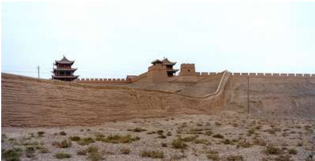
Figura 1 – Uma secção de muralha em taipa no extremo oeste da Grande Muralha, Jiayuguan, Gansu, China.
