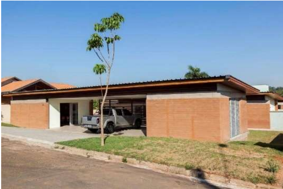
Figura 8 – Casas Colinas, Arquiteto Marcio V Hoffmann
