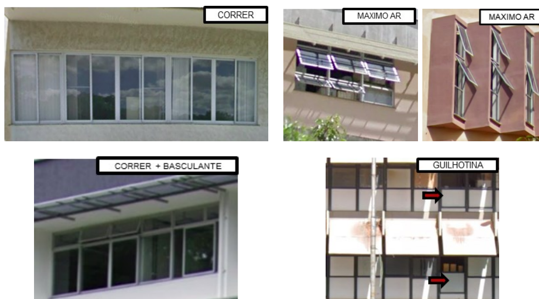
Figura 32 - Tipos de janela considerados no levantamento de dados para as salas de aula
