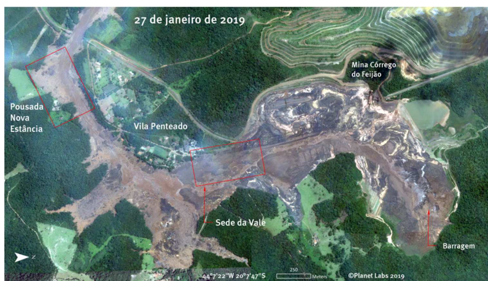
FIGURA 13 - Imagem de satélite exibe a região onde estava localizada a barragem B1 após o seu rompimento, bem como a Mina Córrego do Feijão, a Sede da Vale e a Pousada Nova Estância
