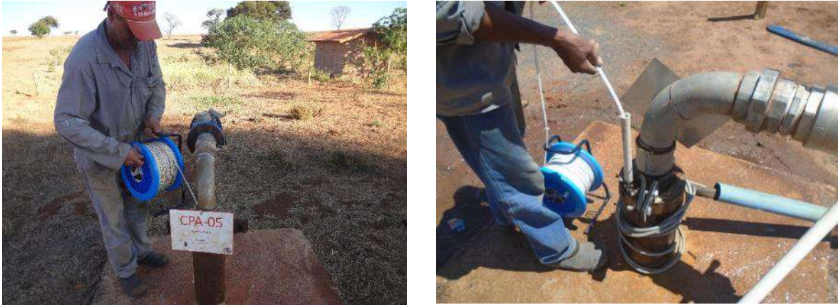
Foto 9: Leituras de nível d'água com medidor de nível manual.
