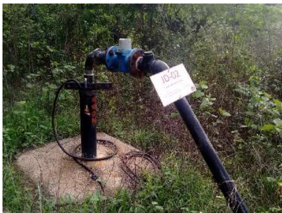
Foto 5: Poços tubulares de bombeamento da bateria, exemplificados em cada um dos distintos setores da fazenda Santa Mônica (STM-07, ITA-08, J-06, CPA-02, JD-02 e STI-07).
