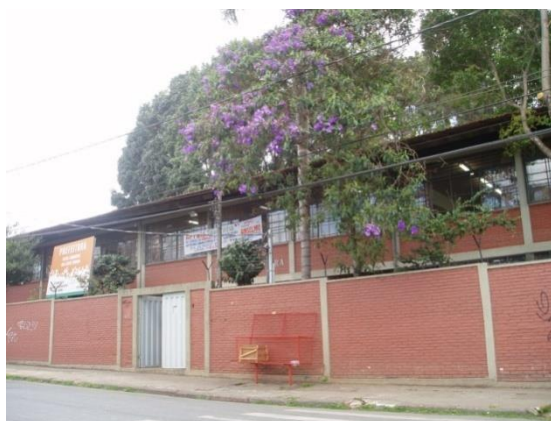
Fig. 1 Vista da entrada principal da escola.
