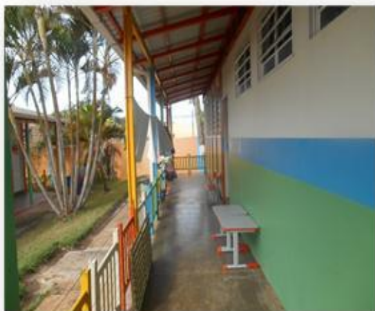
FOTO 1 – Corredor que dá acesso a sala do berçário. Escola Mun de Edu. Inf. Maria Cândida/ Igarapé / junho - 2015.
