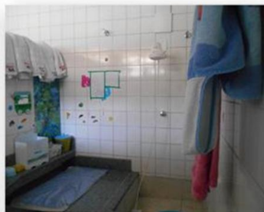
FOTO 8 – Banheiro do berçário . Escola Mun de Edu. Inf. Maria Cândida/ Igarapé / junho - 2015.
