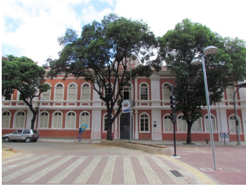
Figura 6: Vista frontal do prédio com visão da pista do MOVE. Fonte: Arquivo pessoal.
