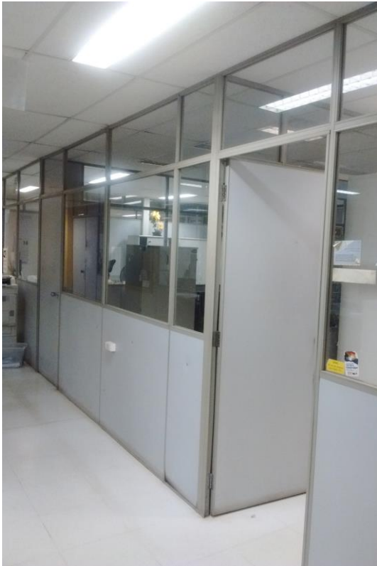
Foto 21 – Setor do CEDECOM – Antes
