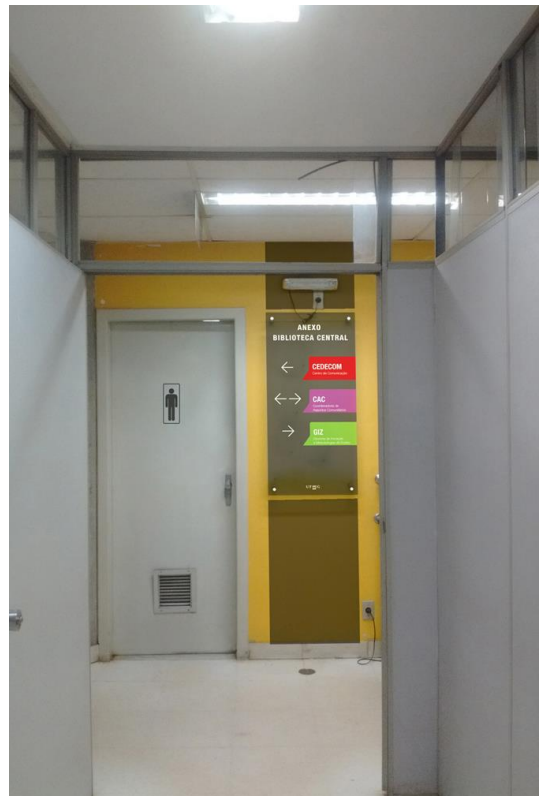
Foto 8 – Início corredor principal – Depois
