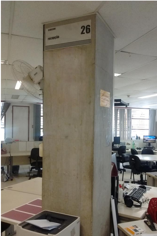
Foto 25 – Placa coluna CEDECOM – Antes
