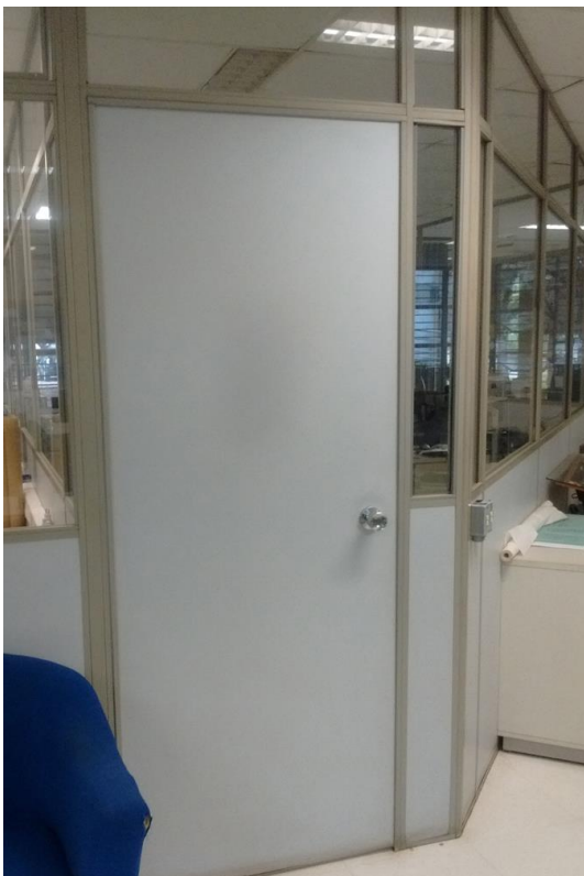
Foto 23 – Setor do CEDECOM – Antes
