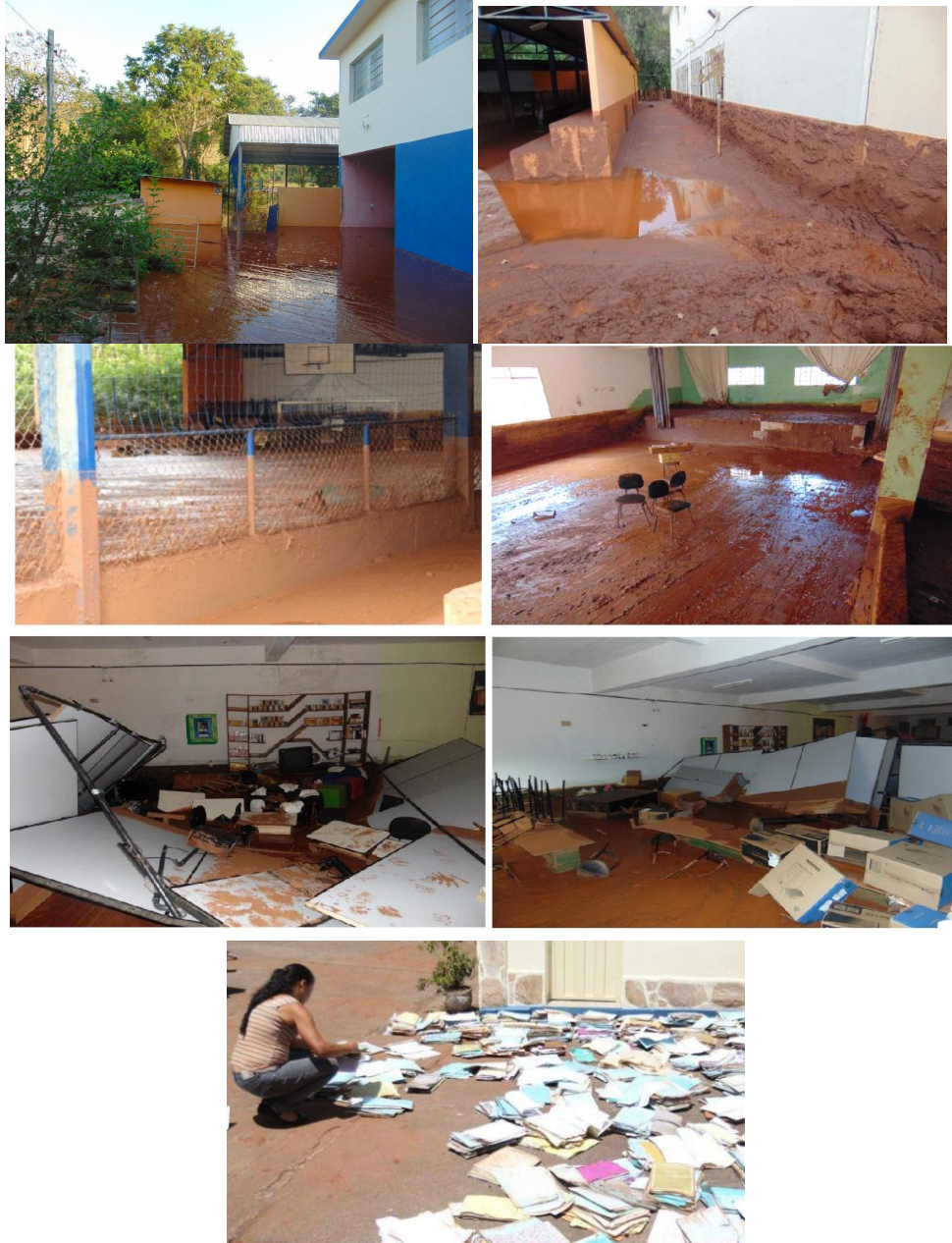
Figura 7 – Espaços da escola com lama do rompimento da barragem de Fundão.
