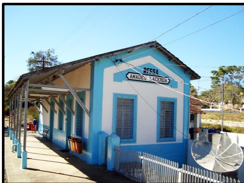
Figura 44 – Fotografia da fachada da Estação Ferroviária de Amadeu Lacerda, atualmente
