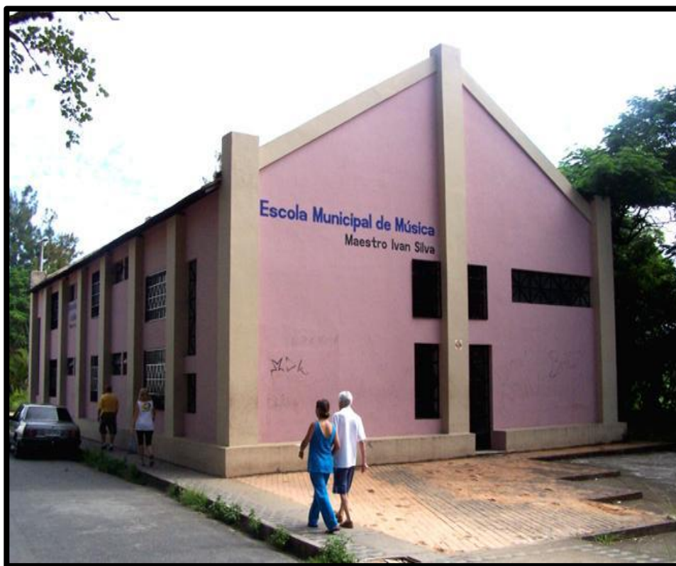
Figura 8 – Fotografia da fachada da Escola Municipal de Música Maestro Ivan Silva
