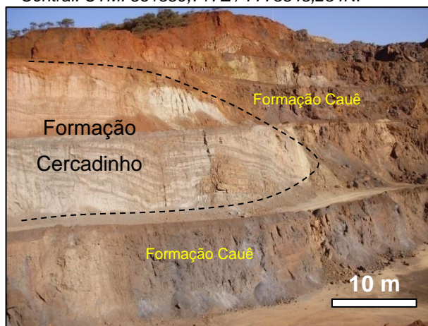
Foto 3.22 – Sucessão de filito e quartzito da Formação Cercadinho envelopados por itabirito da Formação Cauê. Visada para sudoeste. Local: Mina Central. UTM: 561078,29E/7774016,131N.
