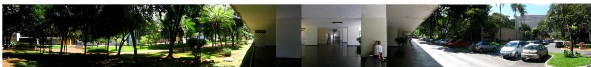
Figura 115 - Permeabilidade dos pilotis dos blocos residenciais.
