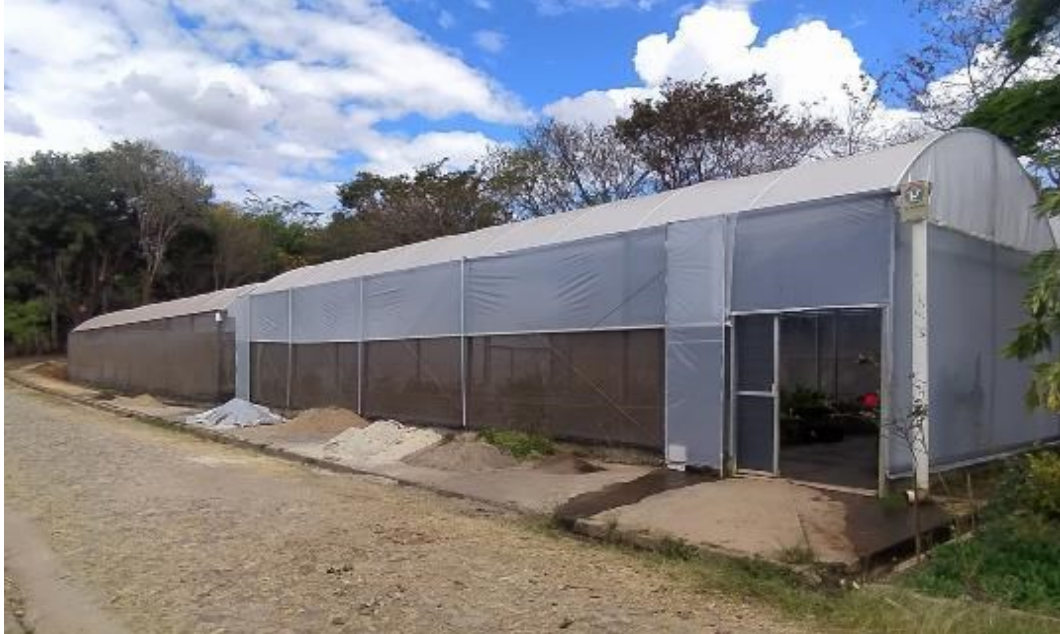
Figura 5 - Estufa de micro nebulização, enraizamento de material propagativo, vista lateral externa
