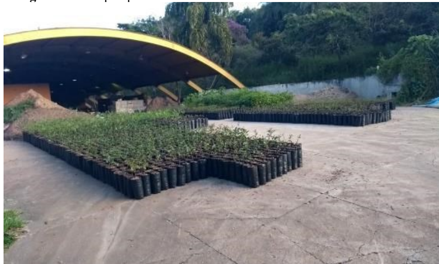
Figura 13 - Galpão para mistura de substrato e armazenamento de insumos 3
